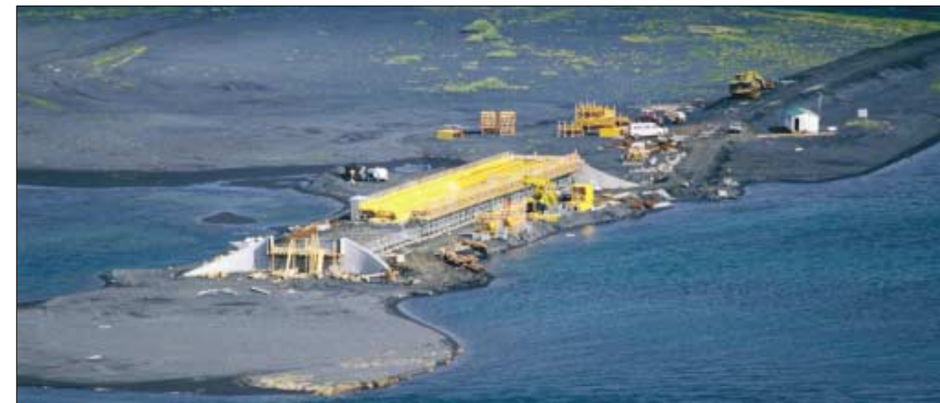
Brúargerð á Lónsós í Öxarfirði í júlí. Verktaki er Vík ehf. á Húsavík. Mynd af vegafarmkvæmdum á sama stað er á baksíðu.
