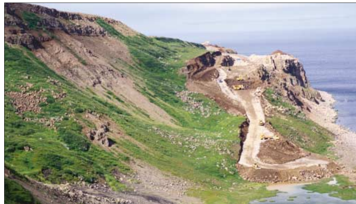
Norðausturvegur í Öxarfirði. Þessi vegagerð kemur í stað núverandi vegar um Auðbjargarstaðarbrekku og tengist nýrri brú á Lónsós. Verktaki er Ístak hf.
