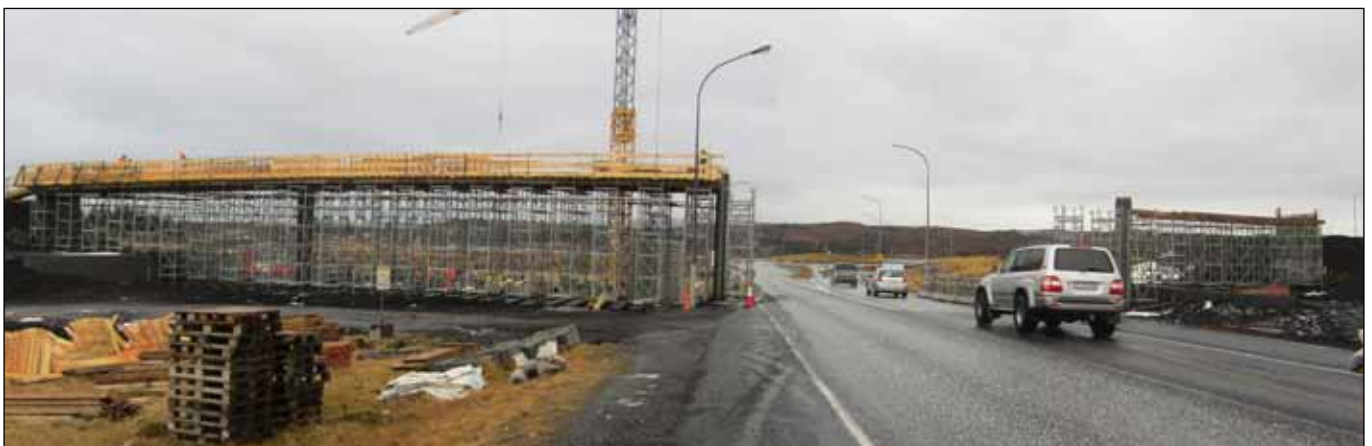
Göngubrú yfir Breiðholtsbraut á milli Seláss og Norðlingaholts í byggingu 22.10.2014.
