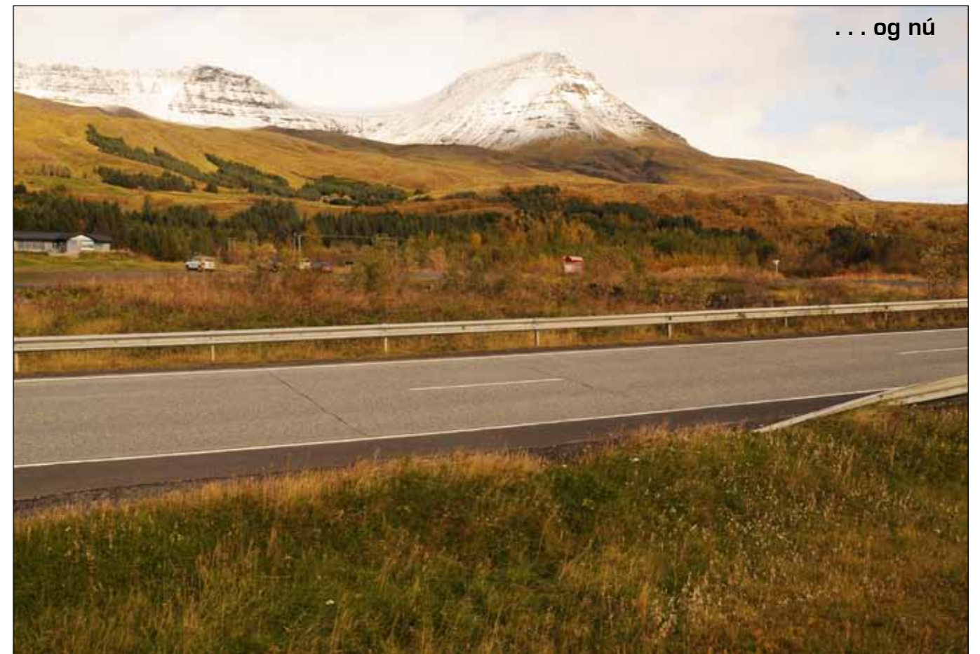
Sami kafli Vesturlandsvegur í október 2014. Steypta slitlagið er það sama og lagt var fyrir 42 árum sem er Íslandsmet í endingu.
