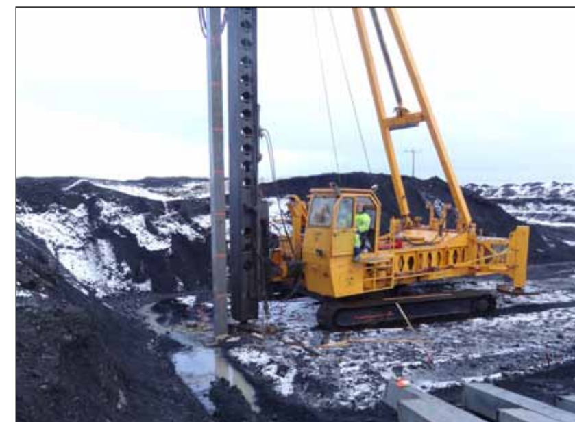
Byrjað á nýrri brú yfir Múlakvísl. Staurar reknir niður, 23.01.2013.
