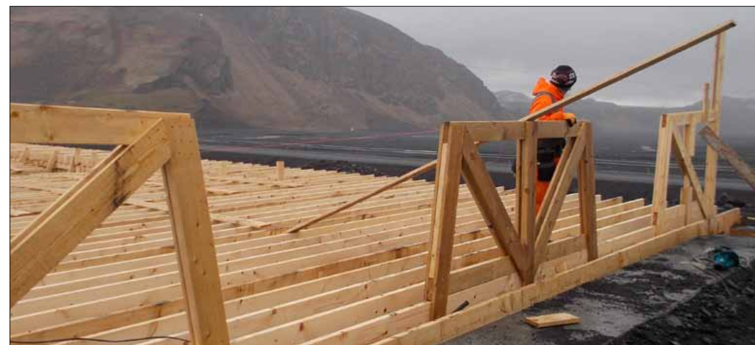
Uppsláttur undir brúardekk, 03.04.2014.
