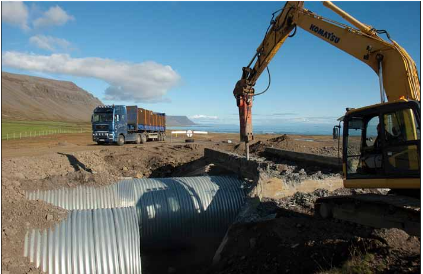
Hrísnesá á Barðaströnd. Ræsi sett í stað einbreiðrar brúar sem var rifin.
