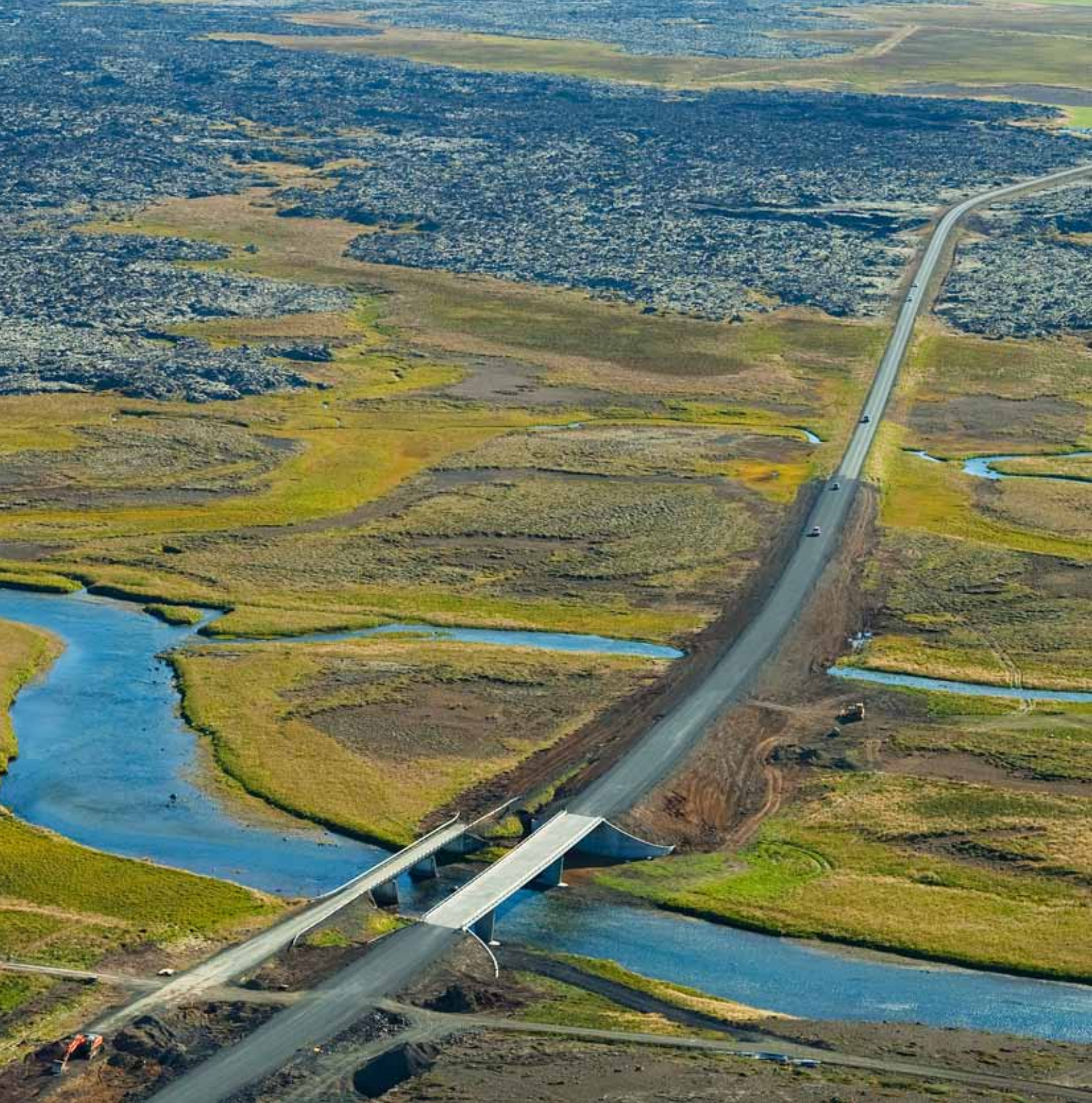
Ný brú á Haffjarðará á Snæfellsnesvegi. Með þessari tvíbreiðu brú fer af síðasta einbreiða brúin á leiðinni frá Reykjavík til Stykkishólms. Gamla brúin verður rifin nú í lok október. Ljósmynd: Mats Wibe Lund.
