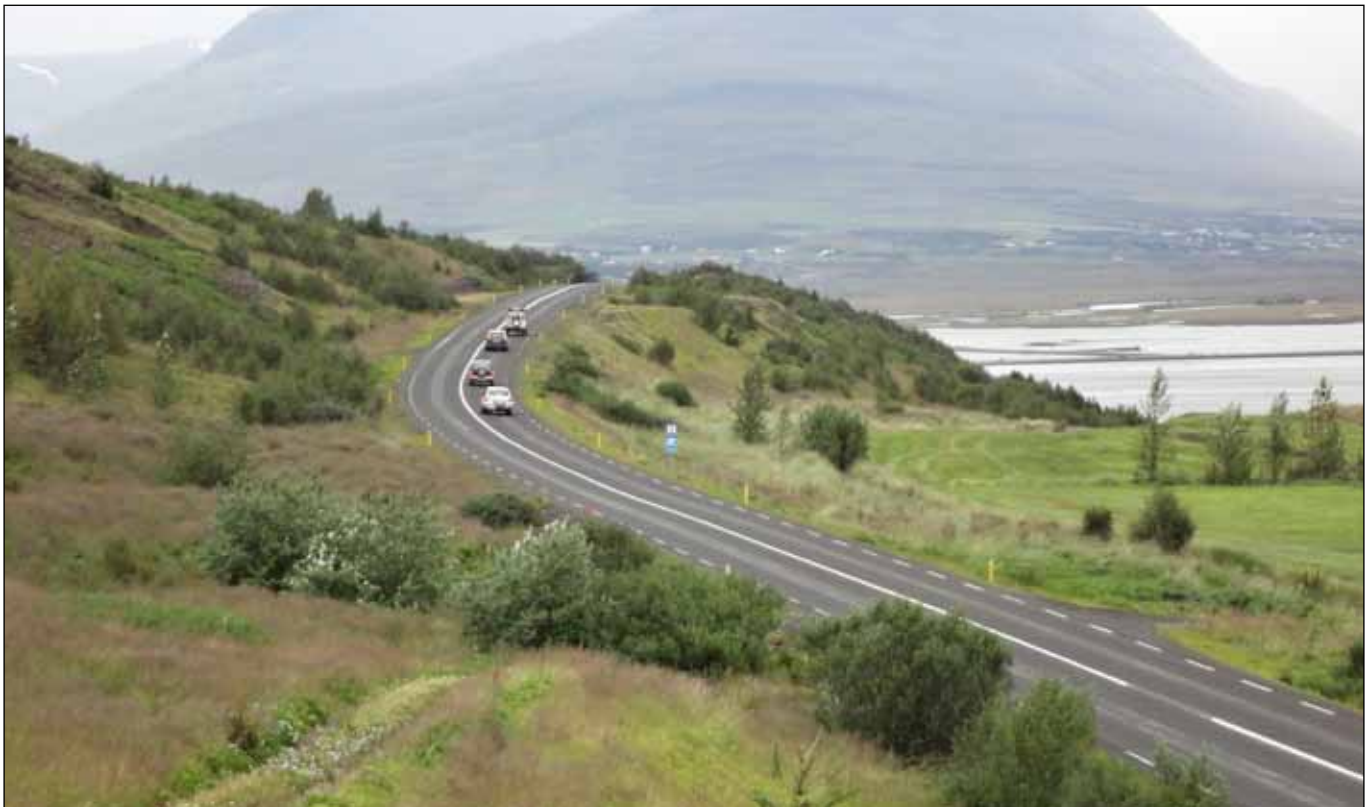
Hringvegur (1) austan Akureyrar. Á þessum stað verður sett upp bráðabirgðabráú yfir veginn vegna framkvæmda við Vaðlaheiðargöng. Mynd: Guðmundur Birkir Guðmundsson.
