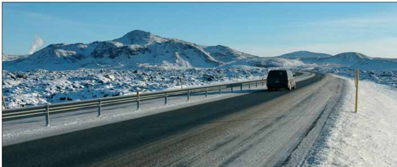
Hringvegur (1) í Svínahrauni. Víravegrið aðskilur akstursstefnur á þessum kafla, 2+1 vegur.
