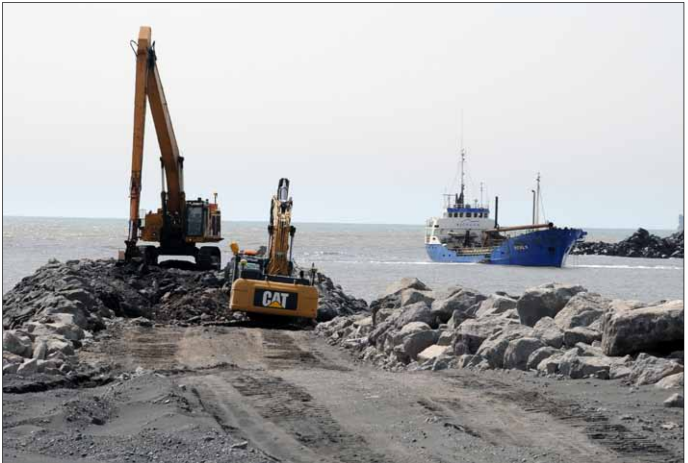
Unnið við innri varnargarð í Landeyjahöfn 8. júlí 2010. Dýpkunarskip í baksýn.
