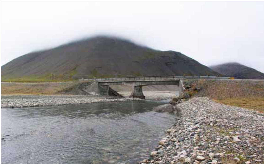
Einbreið brú yfir Fjarðará í Lóni frá árinu 1960 verður nú rifin og tvö ræsi sett í staðinn.
