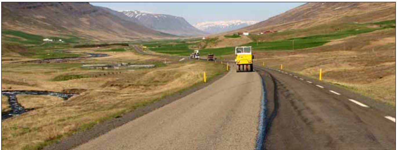
Yfirlögn klæðingar í Öxnadal. Í þessu blaði eru auglýst þrjú útboð á yfirlögnum, sjá bls. 7. Mynd: Hafdís Eygló Jónsdóttir.
