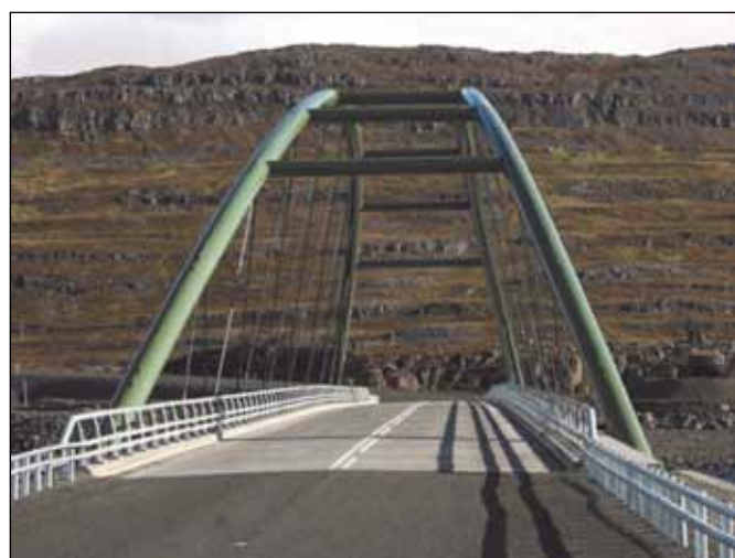
Nýbygging, Djúpvegur (61), brú yfir Mjóafjörð.
