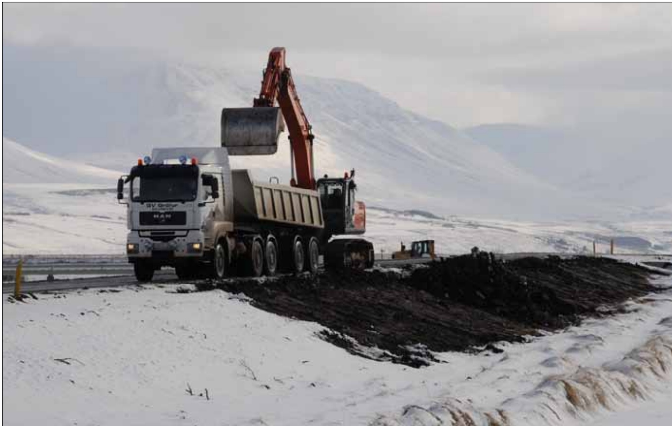
Eyjafjarðarbraut vestri. Unnið í vegfláa. Verktaki við undirvinnu er G.V. Gröfur ehf., Akureyri. Árni Helgason ehf. sér um bikfestun.
