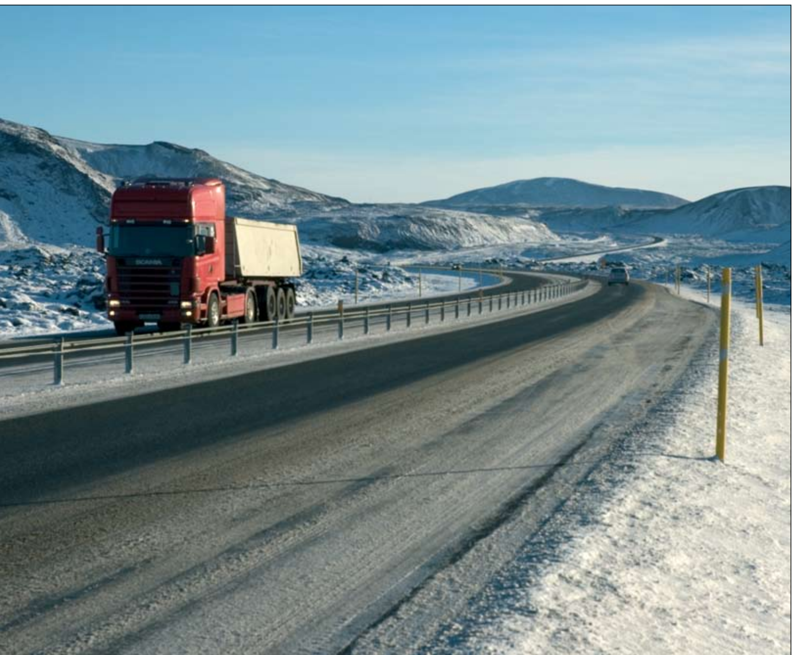
Hringvegur (1) Suðurlandsvegur. Núverandi 2+1 kafla í Svinahrauni. Víravegrið aðskilur akstursstefnur.
