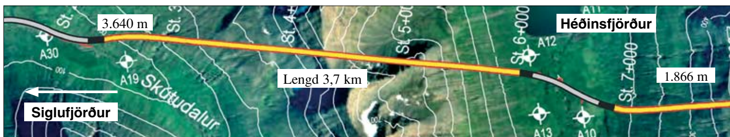
Staða framkvæmda við Héðinsfjarðargöng 9. mars. 2009. Sprengingum frá Siglufirði til Héðinsfjarðar lauk 21. mars 2008.
