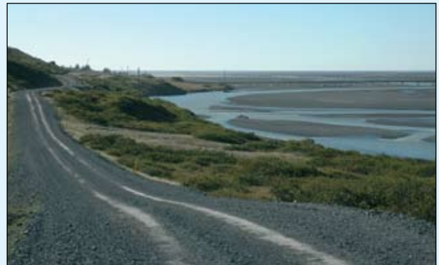
Vegur að Grænuhlíð í Lóni, héraðsvegur.
