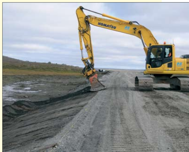
Hringvegur (1), Ármótasel - Skjöldólfsstaðir, Héraðsverk ehf. Flái sléttaður.
