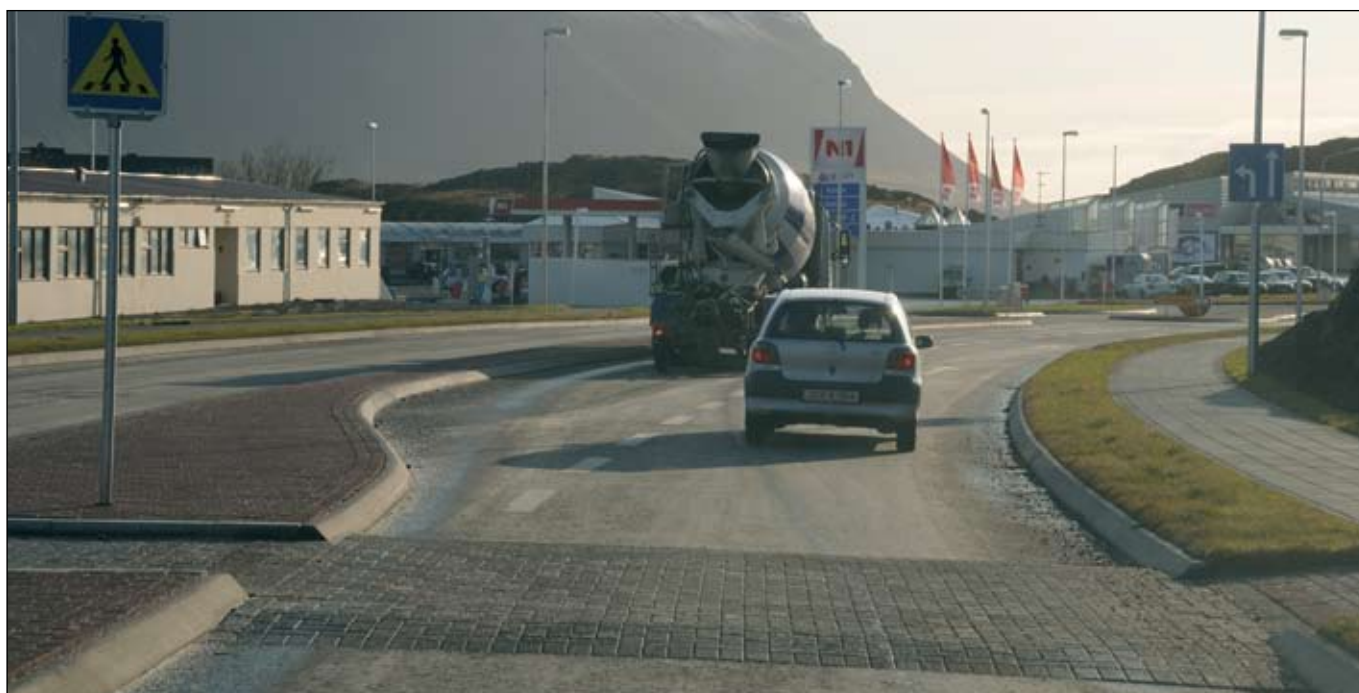
Hringvegur (1), gatnamót við Borgarbraut. Verk fullbúið. Verktaki var Borgarverk Borgarnesi ehf.
