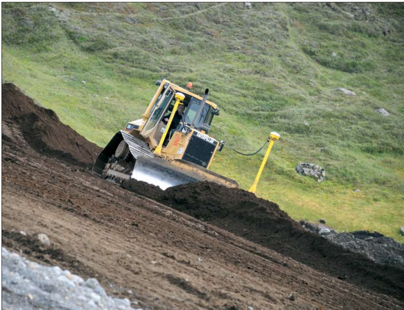
Hringvegur (1), Ármótasel - Skjöldólfsstaðir, 4. september 2008. Flái jafnaður. Verktaki: Héraðsverk ehf.
