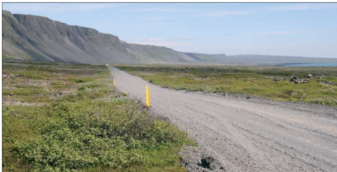
Suðurstrandarvegur (427), Krýsuvíkurvegur - Þorlákshafnarvegur. Núverandi vegur. Verktaki nýbyggingar er KNH ehf.
