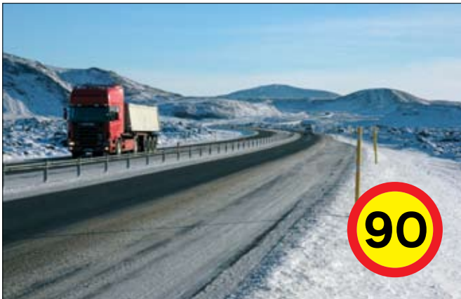
Vegur með bundnu slitlagi, akstursstefnur aðgreindar með vegriði (2+1): 90 km/klst. Er nú 90 km/klst.
