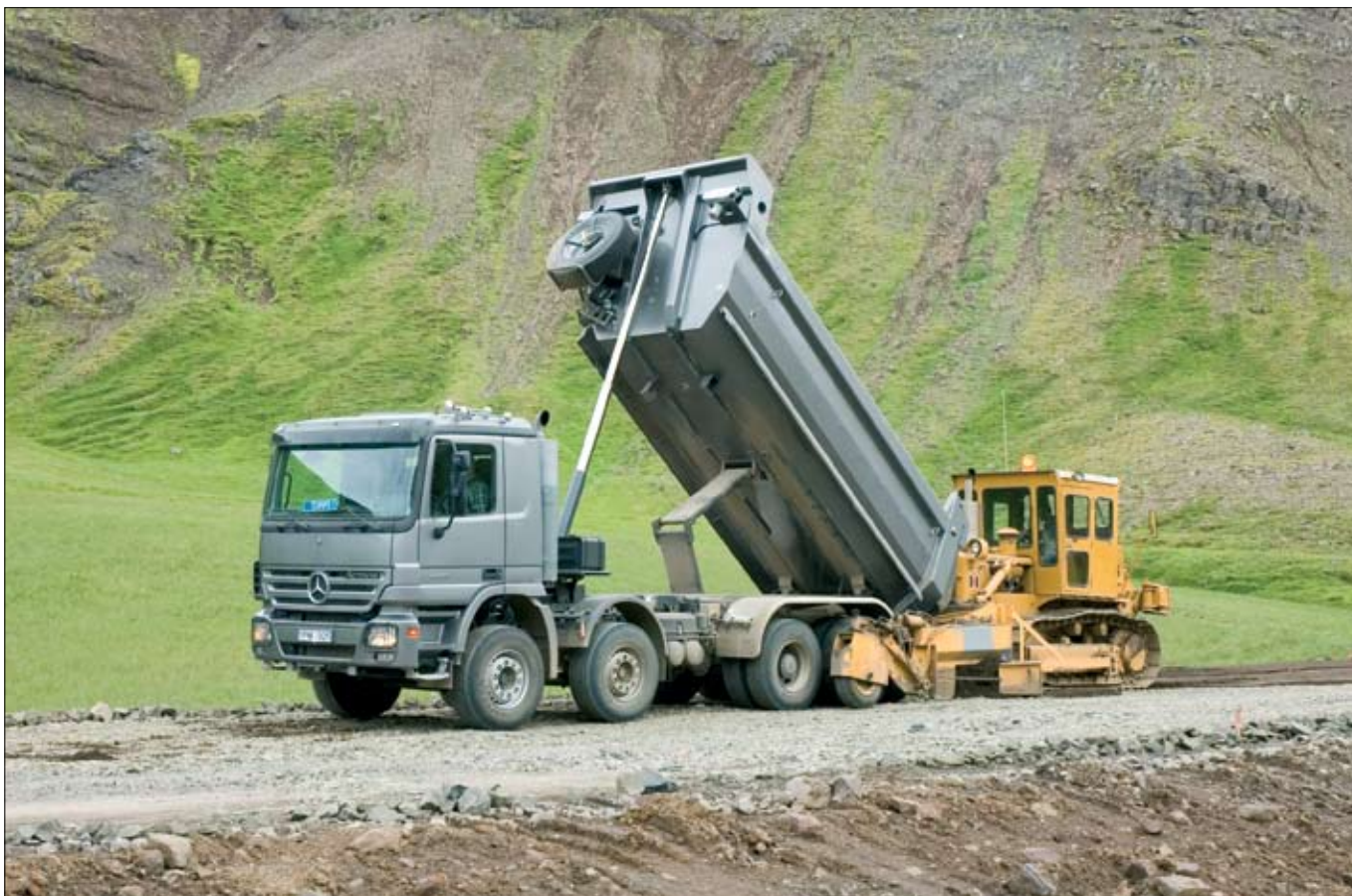
Vegagerð á Vestfjarðavegi (60) um Svínadal í Dalasýslu. Efra burðarlag lagt út. Verktaki er KNH ehf. á Ísafirði.
