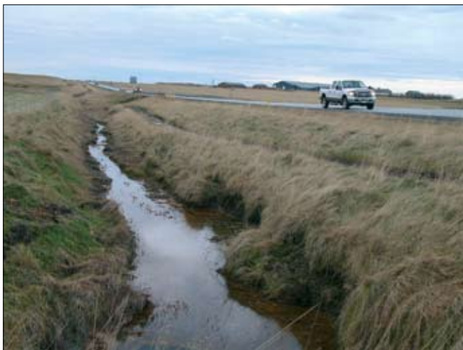
Hættulegir skurðir við hlið Suðurlandsvegjar. Mynd EuroRAP.
