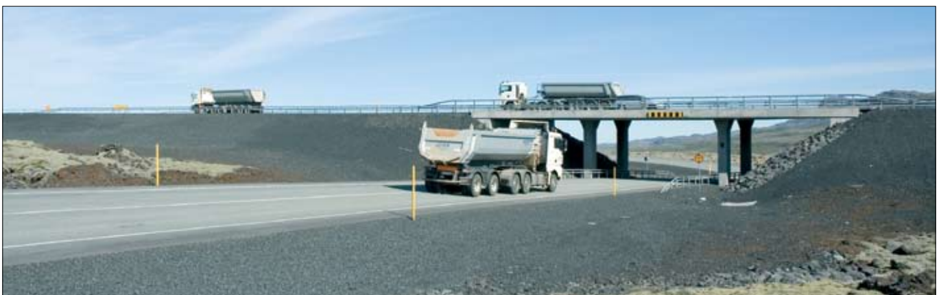
Mislæg vegamót Hringvegur (1) og Prengslavegar (39).
