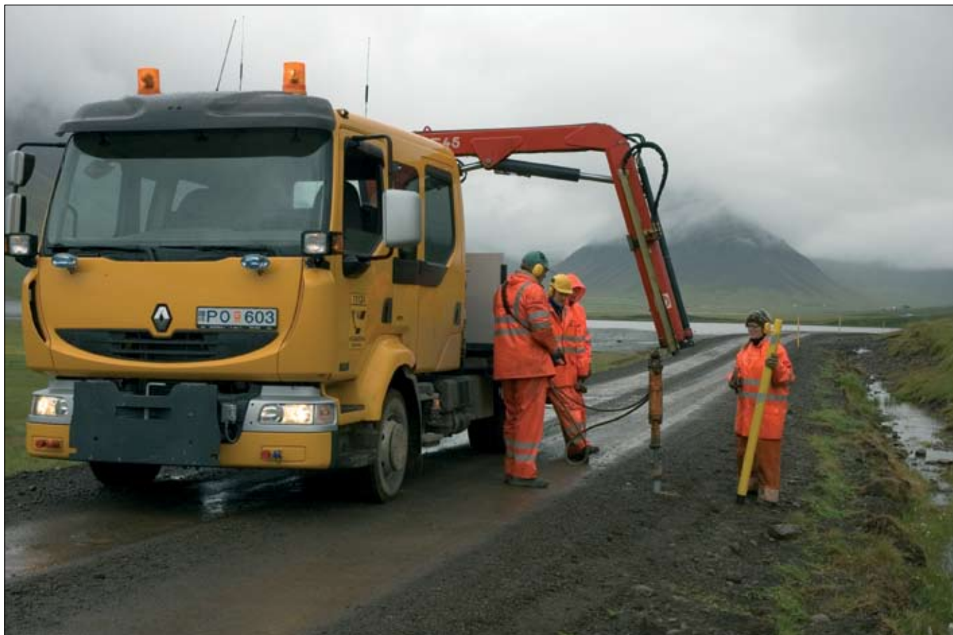
Veturinn undirbúinn fyrir vestan. Starfsmenn Vegagerðarinnar á Ísafirði reka niður snjóstíkur við Öndarfjarðarveg (627) þann 8. ágúst sl.
