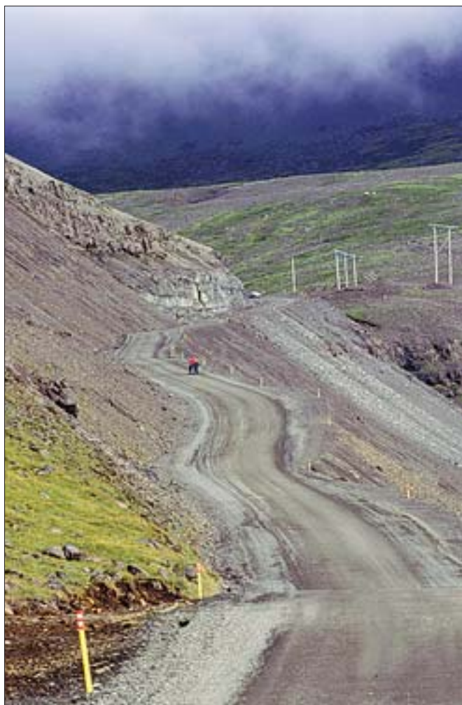
Vegurinn í Almannaskarði liggur nú um skriðu með um 16% halla sem er mesti bratti á Hringveginum.
