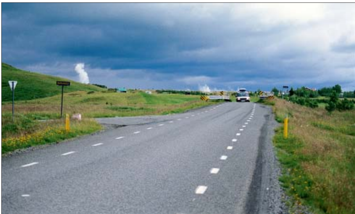
Hér fyrir neðan eru birtar niðurstöður útboðs endurbóta á Biskupstungnabraut (35) um Laugaá skammt vestan við Geysi. Eins og sjá má er þarna einbreið brú sem er sérstaklega hættuleg vegna þess að vegurinn er lægri báðu megin brúar og útsýni því verulega skert. Einnig eru vegamót alveg við brúna. Vegurinn verður nú hækkaður og áin sett í rör.
