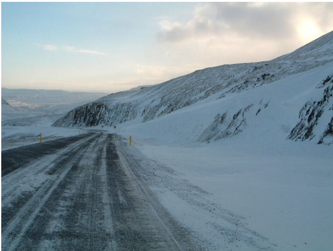
Mynd 1. Myndin sýnir skafl sem er skáskotinn inn að vegi. Stefna hans er svipuð og stefna dalsins. Myndin er frá neðsta hluta Miðdalsgils á Vestfjarðarleið yfir Bröttubrekku. Ljós. Árni Jónsson, Feb. 2004.
