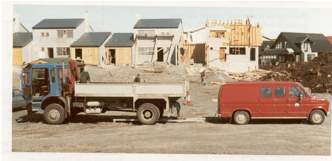
Mynd 62. Uppstilling við plötupróf
