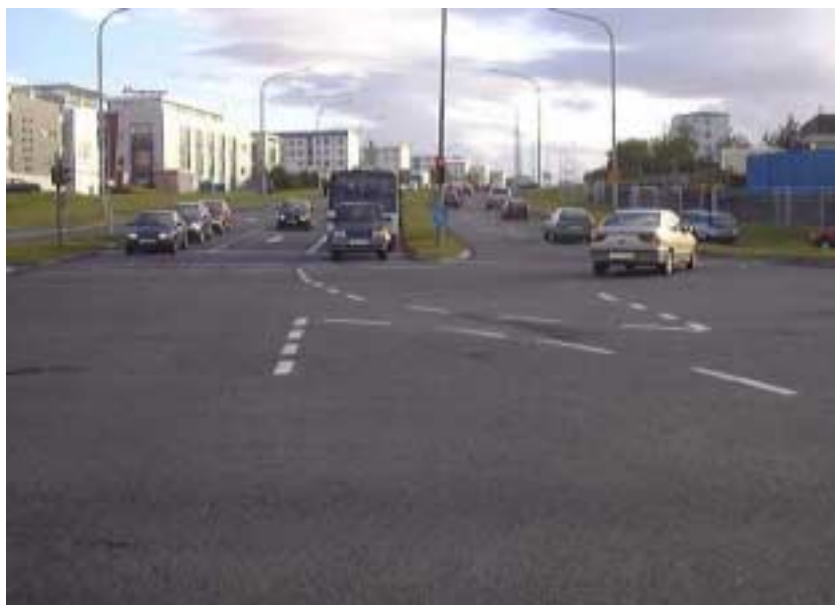
Mynd 21: Kringlumýrarbraut/Laugavegur-Suðurlandsbraut. Rangt málaðar stýrilínur fyrir óvarða vinstribeygju
