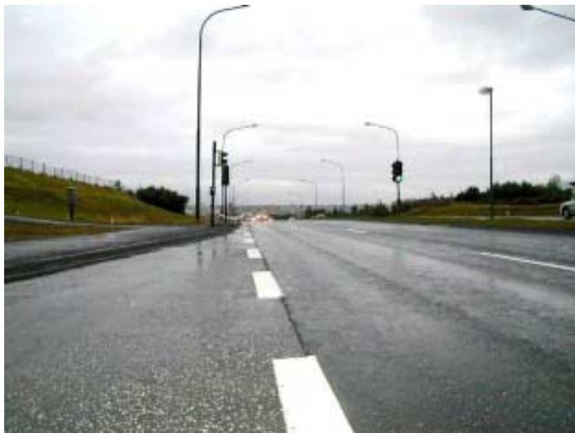
Mynd 38: Gangbraut efst á hálsi – skert útsýni fyrir ökumenn og gangandi hvors til annars
