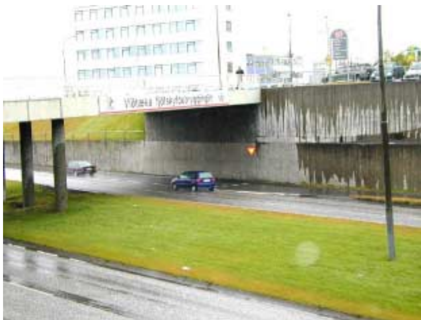
Mynd 26: Aðrein í Kópavogsgjá – Slæmt útsýni, löng þríhyrningslaga aðrein ...
