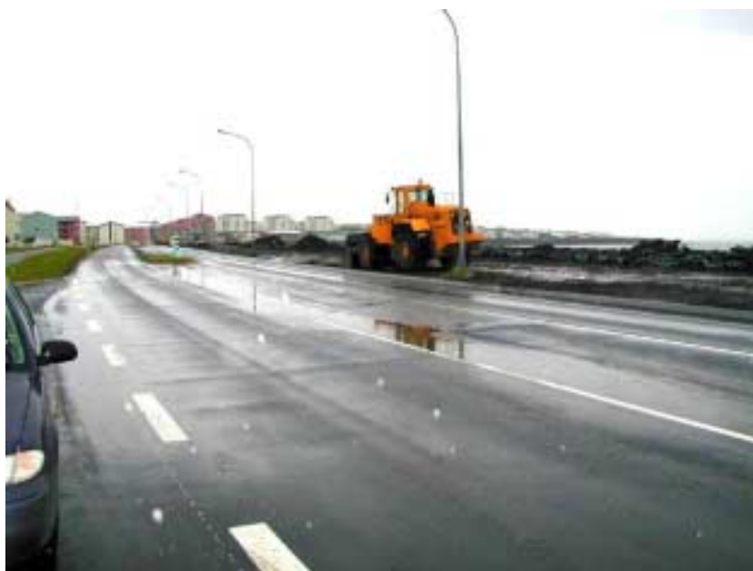
Mynd 33: Málaðar útlínur miðeyju á Eiðsgranda. Klára mætti dæmið með því að mála bannsvæði innan línanna, eða hreinlega leggja graseyju.
