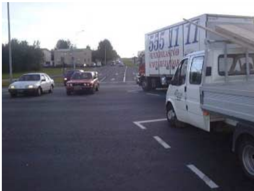
Mynd 22: Grensásvegur/Miklabraut. Rétt málaðar stýrilínur fyrir óvarða vinstribeygju
