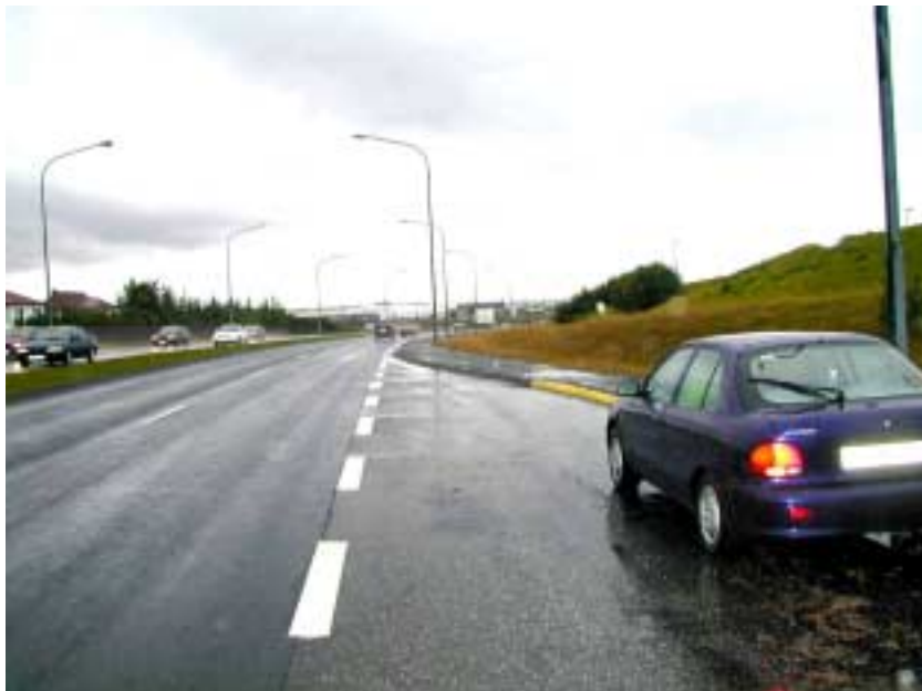
Mynd 16: Hafnarfjarðarvegur við Hraunsholt (Gbr). Of stutt hröðunarrein fyrir almenningsvagna
