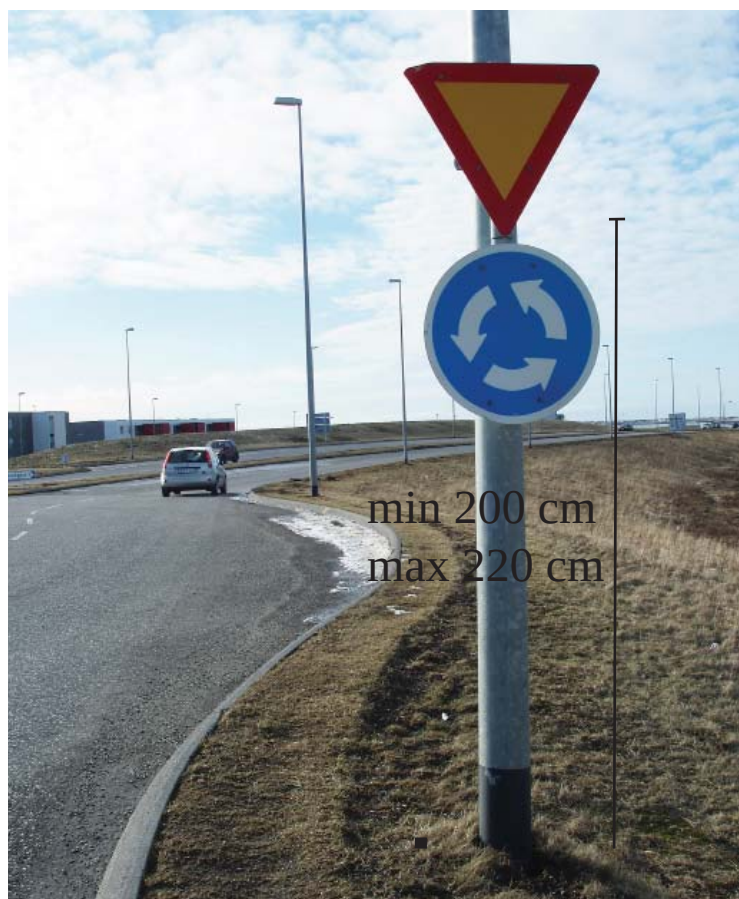
Uppsetning almenna umferðarmerkja á ljósastaur.
