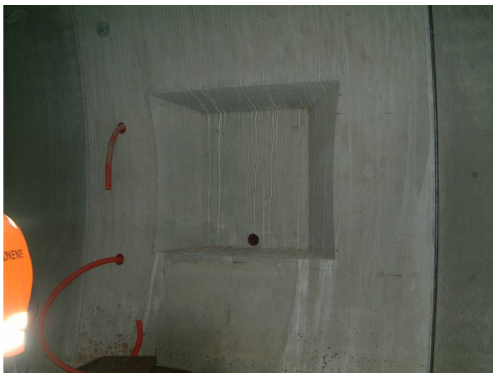
Mynd 4. Forsteypt veggeining með úrtaki fyrir neyðarsíma og slökkvitæki (á 125 m bili).
