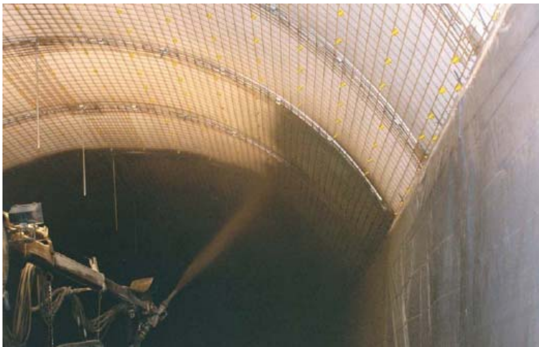
Mynd 5. Ásprautun á vatnasklæðningu í lofti ganga ofan forsteyptra veggeininga.
