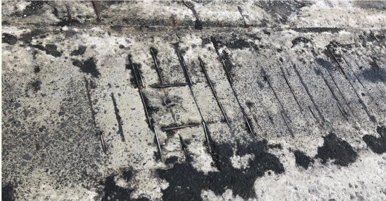
Botnsá á Tálknafirði Byggingarár 1950 Ný brú byggð 2021 með slitlagssteypu
