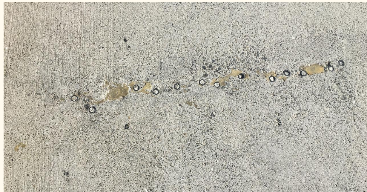
Frágangur á grautunarslöngum í eftirspennukerfi, án slitlagssteypu Gilsfjarðarbrú byggingarár 1997
