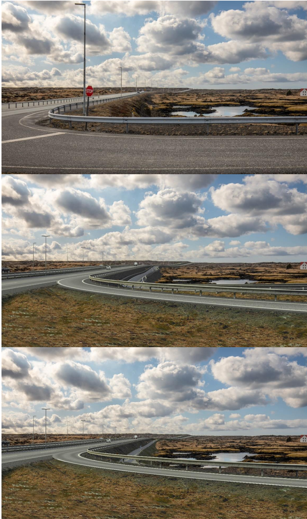
Mynd 6.14 Sjónarhorn 4: Ásýnd núverandi vegar og nýs vegar, valkostur 1a (miðja) og valkostur 1b (neðst). Séð frá vegamótum við álverið og eftir Reykjanesbraut til vesturs. Straumstjarnir og húsið Straumur til hægri.
