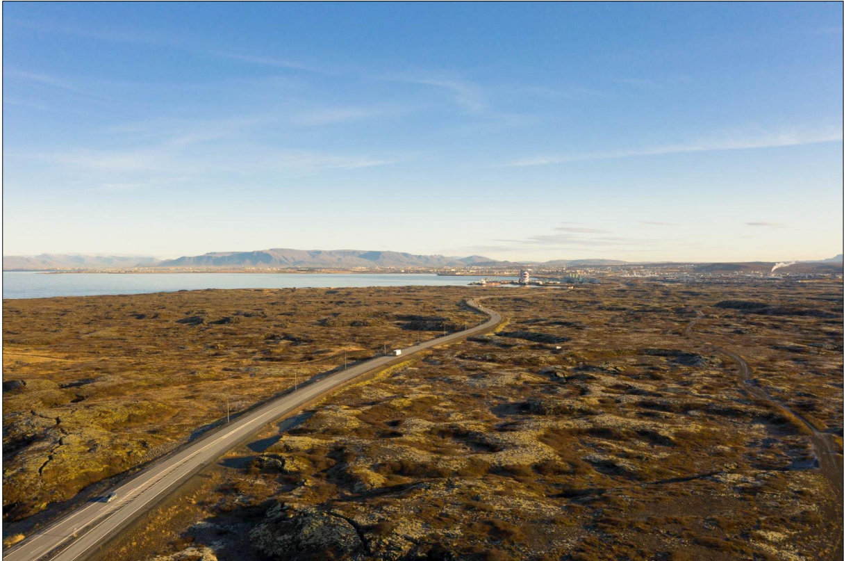
Mynd 2.1 Reykjanesbraut (41-15) séð í norðaustur. Sjá má hvar vegur breytist úr 2+2 aðskildum akreinum í samliggjandi 1+1 veg.
