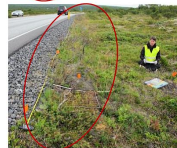
Ásýnd vegfláa einu ári (efri mynd) og tveimur árum (neðri mynd) eftir framkvæmd.
