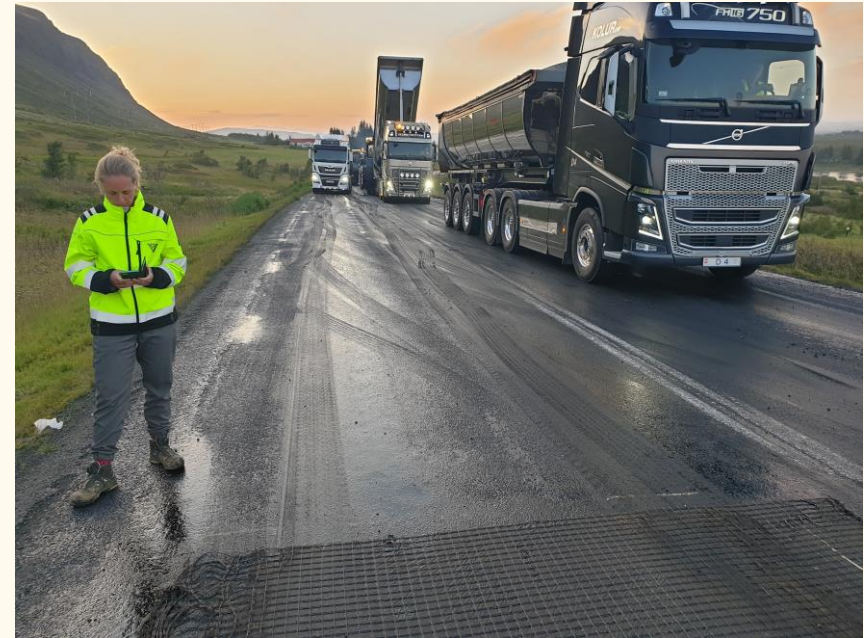
Klæðingaryfirborð lagt nýju malbiki. Tilraun með trefjamottur til styrkingar.
