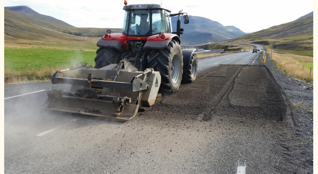
Ójöfnur lagfærðar á stuttum vegarköflum. Ræsaþopp og sig.
