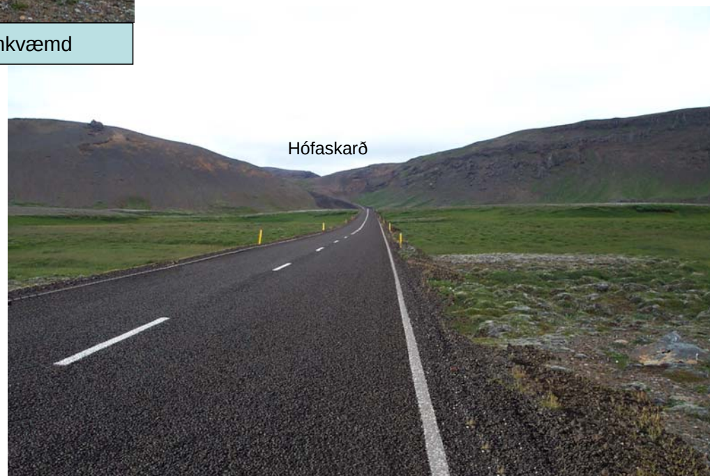
Mynd 30b) 1. Áfangi, u.þ.b. stöð 21.000 til austurs, eftir framkvæmd
