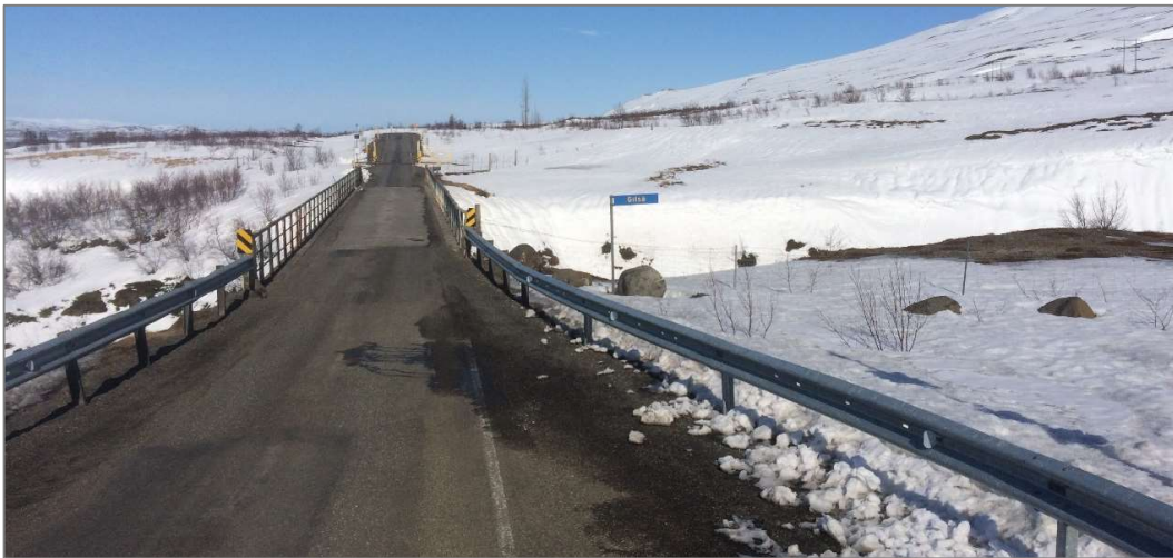
Mynd 10. Aðkoma að brú á Gilsá að sunnanverðu (mynd: Vegagerðin 2020).
