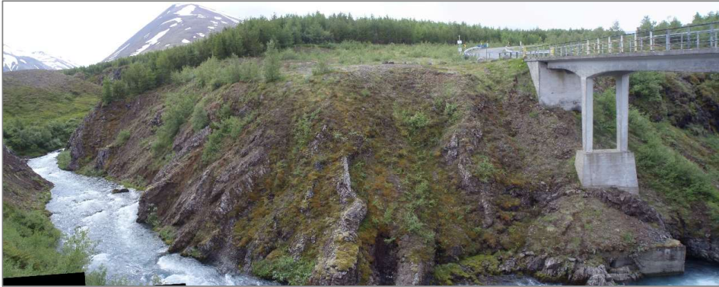
Mynd 14. Fyrirhugað brúarstæði. Horft til suðurs yfir Gilsá (mynd: Vegagerðin 2020).
