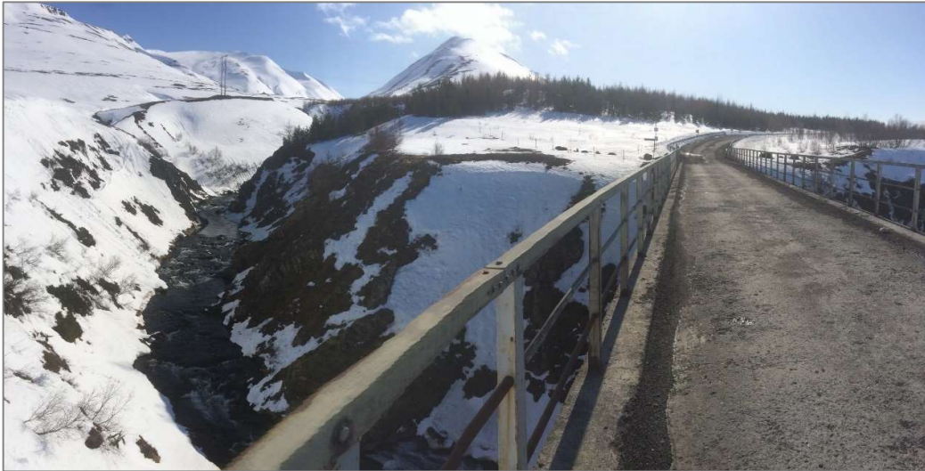
Mynd 18. Núverandi brú og brúarstæði nýrrar brúar á Gilsá (mynd: Vegagerðin, 2020).
