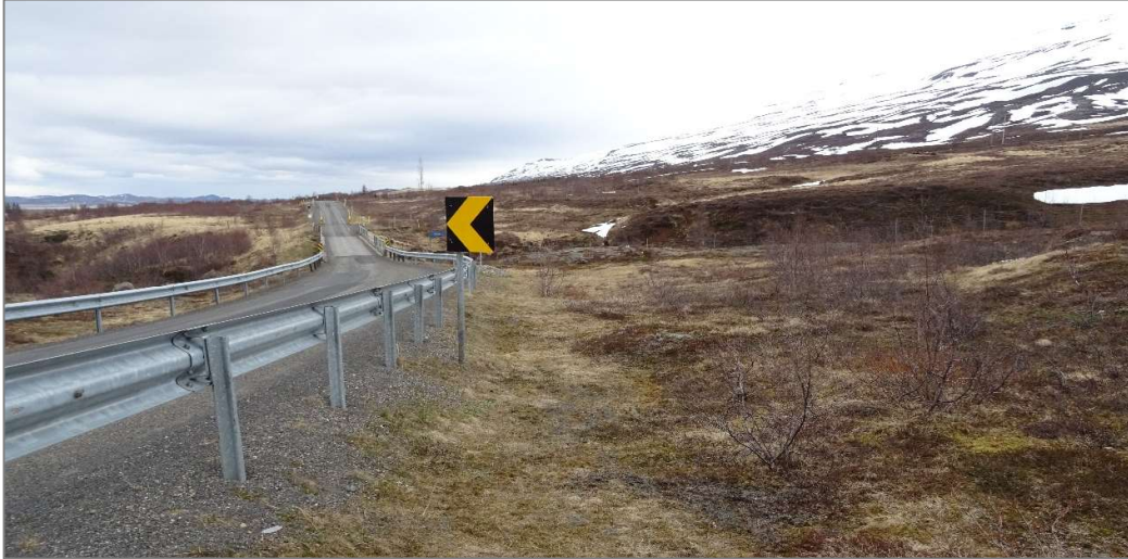
Mynd 16. Fyrirhugað brúarstæði. Horft til norðurs yfir Gilsá (mynd: Vegagerðin 2020).
