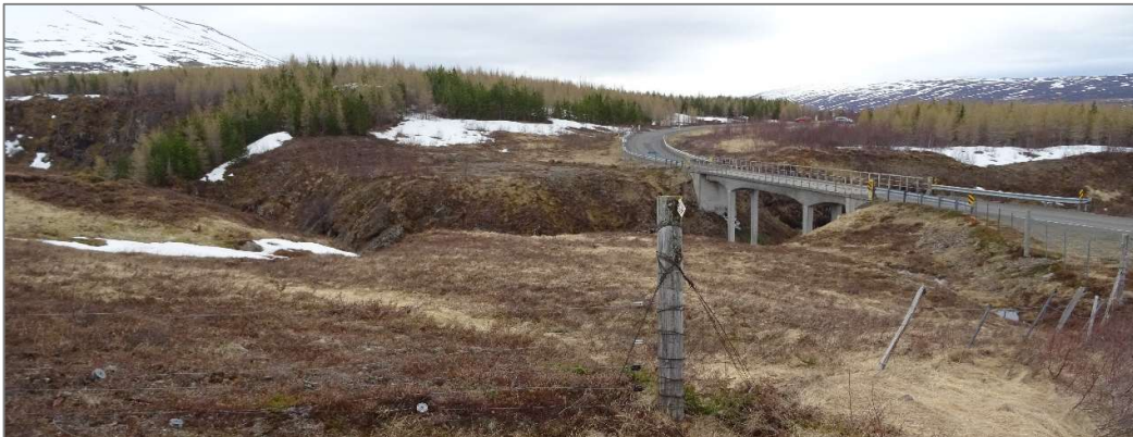
Mynd 15. Fyrirhugað brúarstæði. Horft til suðurs yfir Gilsá (mynd: Vegagerðin 2020).
