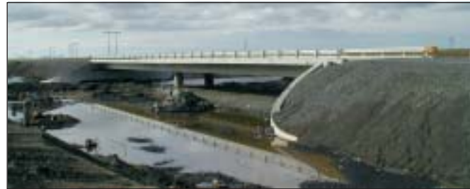
Brúarvinnuflokkur Vegagerðarinnar frá Vík í Mýrdal að störfum við Þverá á Hringvegi austan við Hvolsvöll 23. júlí. Bygging tvíbreiðrar brúar í stað einbreiðrar brúar. Litla myndin hér til hliðar sýnir brúna að mestu tilbúna í byrjun ágúst.
