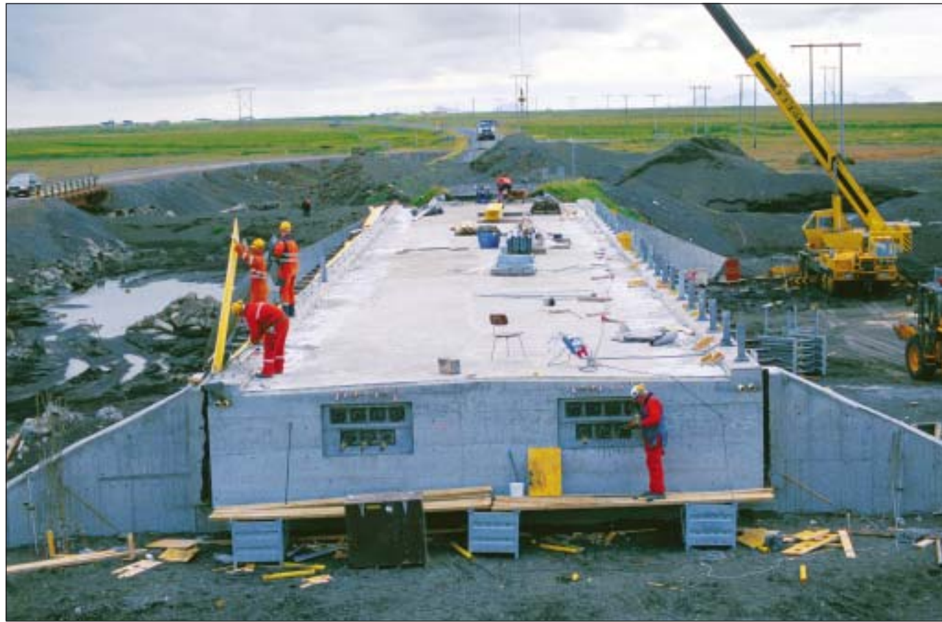
Brúarvinnuflokkur Vegagerðarinnar frá Vík í Mýrdal að störfum við Þverá á Hringvegi austan við Hvolsvöll 23. júlí. Bygging tvíbreiðrar brúar í stað einbreiðrar brúar. Litla myndin hér til hliðar sýnir brúna að mestu tilbúna í byrjun ágúst.
