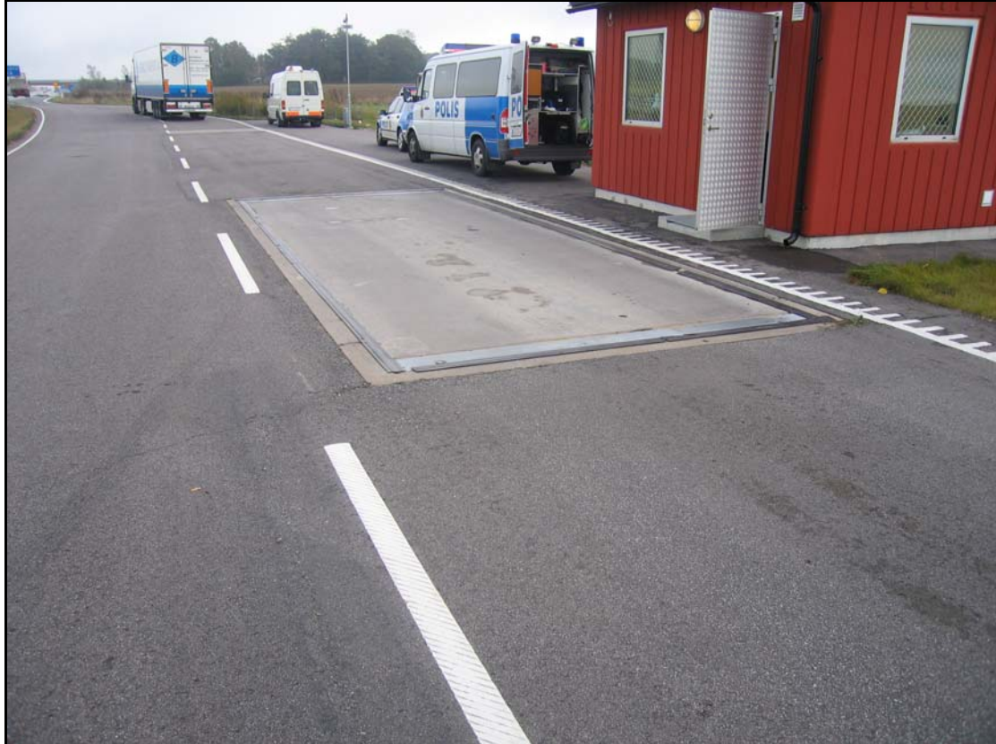
Mynd 7. Föst vog á eftirlitsstað í Hurva við E22 í Svíþjóð (Ljósmynd, Sævar Ingi Jónsson).
