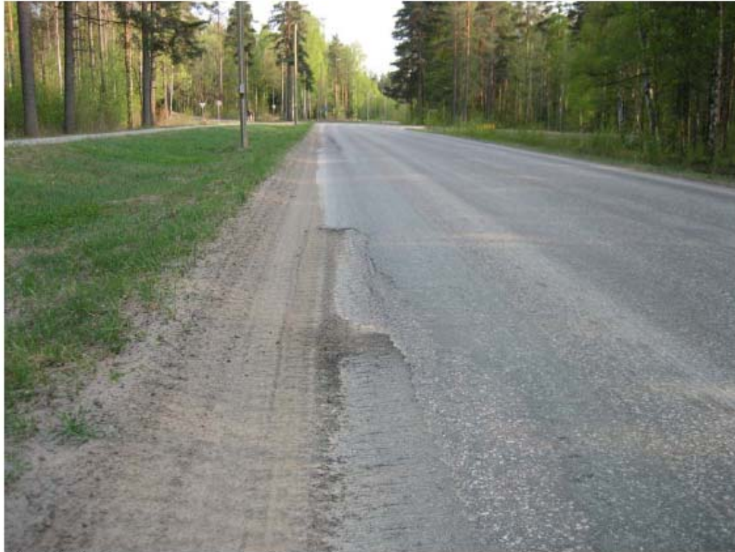
Kuva 3. Päällyste on murtunut tien reunasta.
