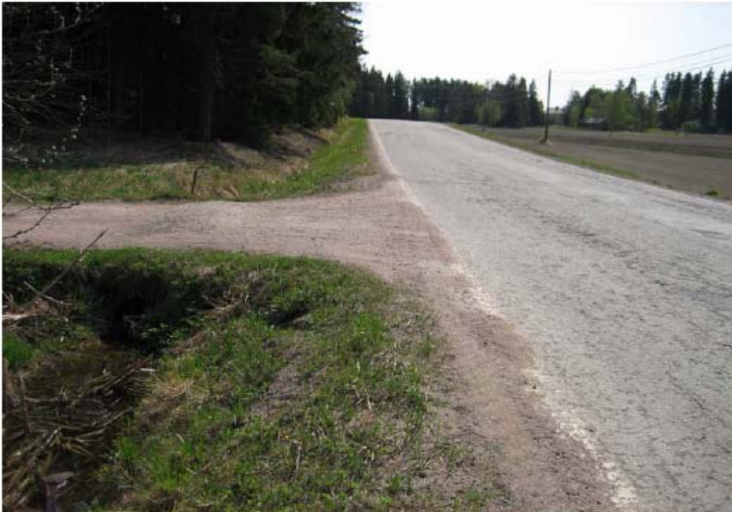
Kuva 2 . Pl 2510 ympäristö: Sivutierumpu routunut ja noussut, vesi ei pääse päätierummulle + lisäksi päätierumpu on tukossa. Tiessä näkyvissä kohteelle tyypillinen vanha, reikiintynyt päällyste.
