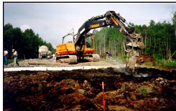
MASSTABILISERINGSARBETE PÅ GÅNG
