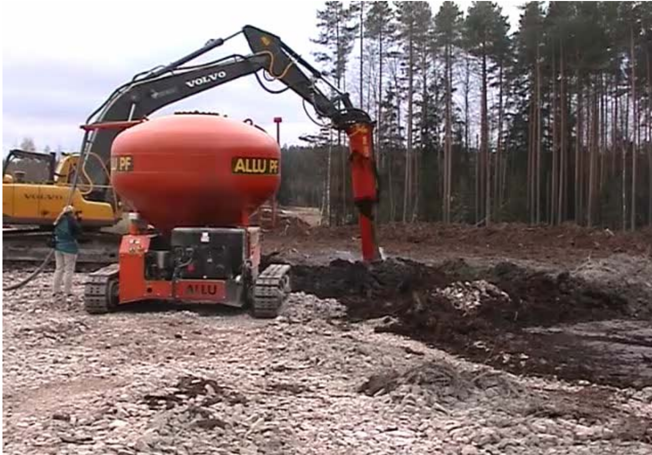
ALLU-stabiliseringsutrustning från Ideachip
