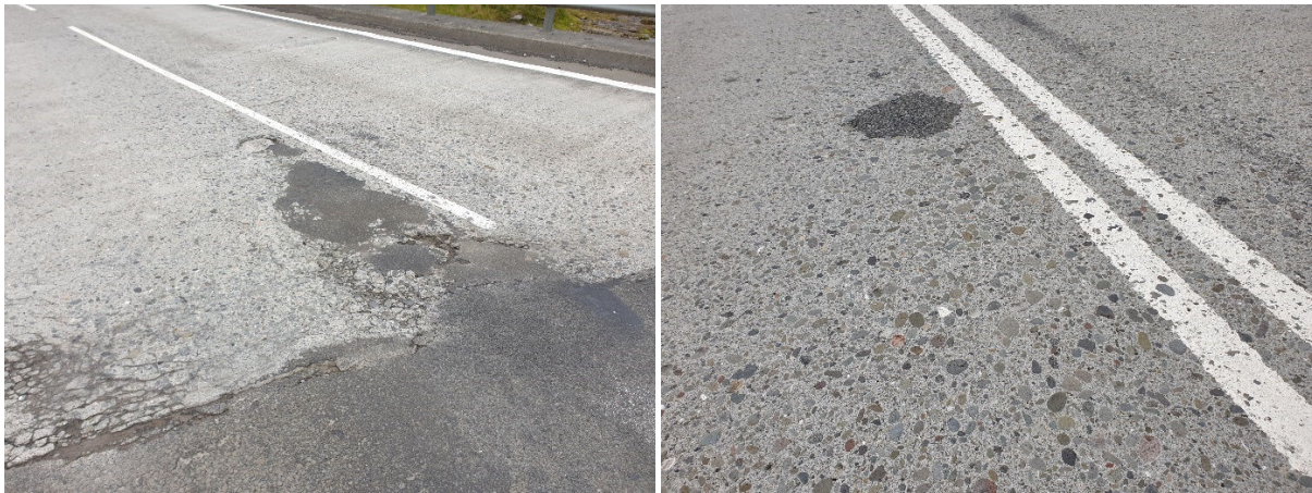
MYND 6.4 Skemmdir í brúargólfum á brúnum í Norðurárdal. Brú við Sveinatungu til vinstri en Sanddalsá til hægri.
