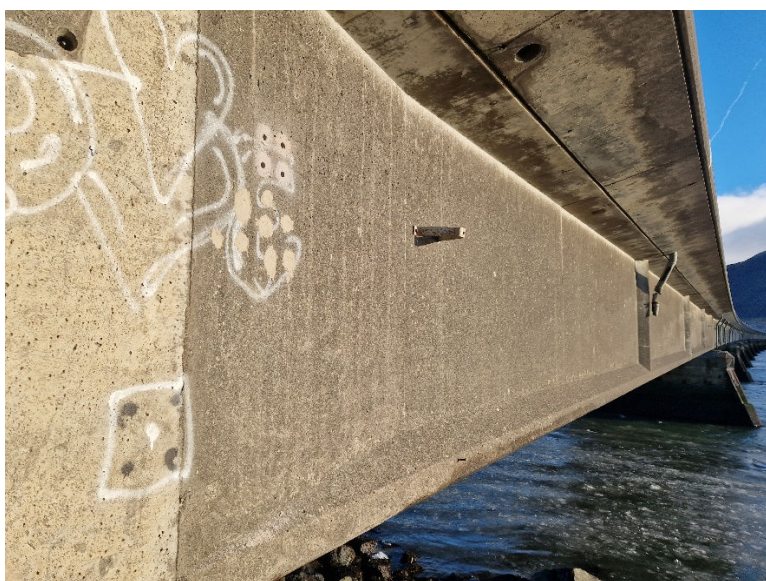
MYND 5.2 Sýni tekin úr norðurenda Borgarfjarðarbrúar. För eftir fyrri sýnatöku á sama stað.
