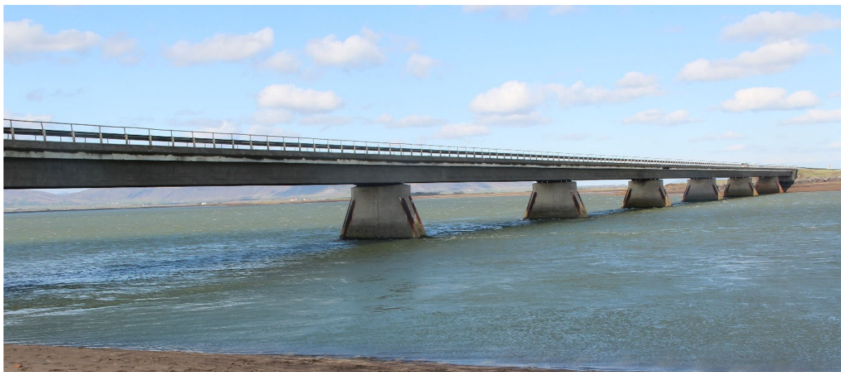
MYND 3.1 Brú á Ölfusárós, Óseyrarbrú.
