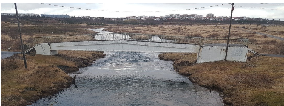
MYND 6.7 Göngubrú á Elliðaár (Dimmu) í Víðidal. Gerð úr forsteyptum þakbitum.
