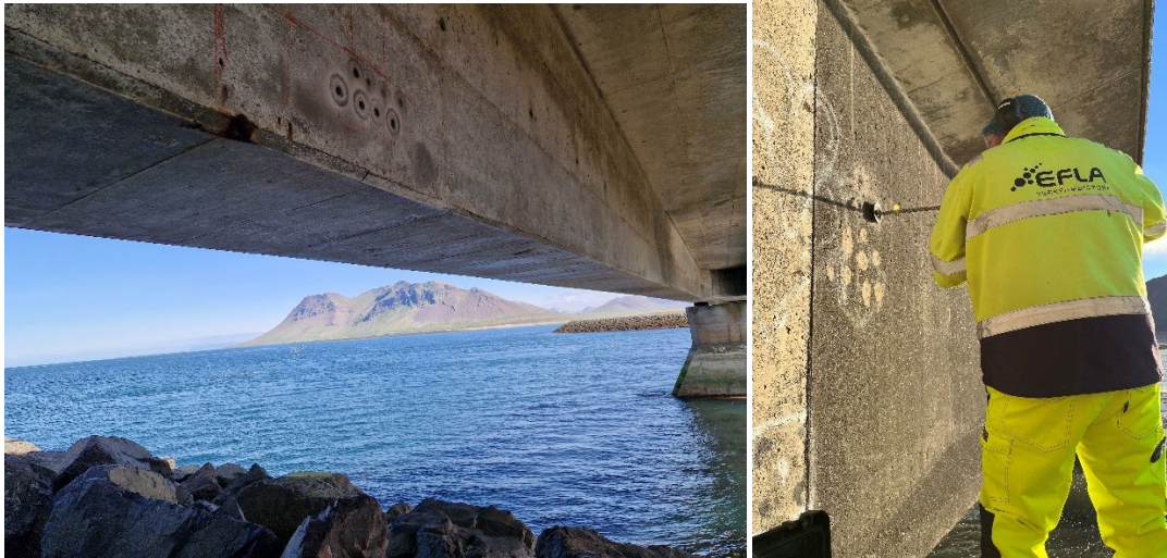
MYND 4.1 Sýnataka úr brúnum yfir Kolgrafarfjörð og Borgarfjörð. Ummerki um fyrri sýnatöku sjáanleg.
