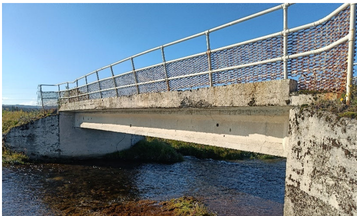
MYND 6.6 Brú á Suðurá í Heiðmörk úr forsteyptum bitum.
