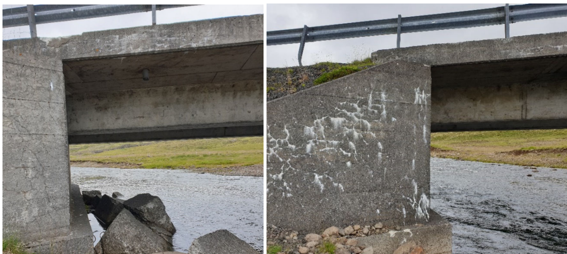
MYND 6.3 Brú á Norðurá hjá Fornahvammi. Skemmdir á brík og stöpli með kalkútfellingum. Bitar óskemmdir.
