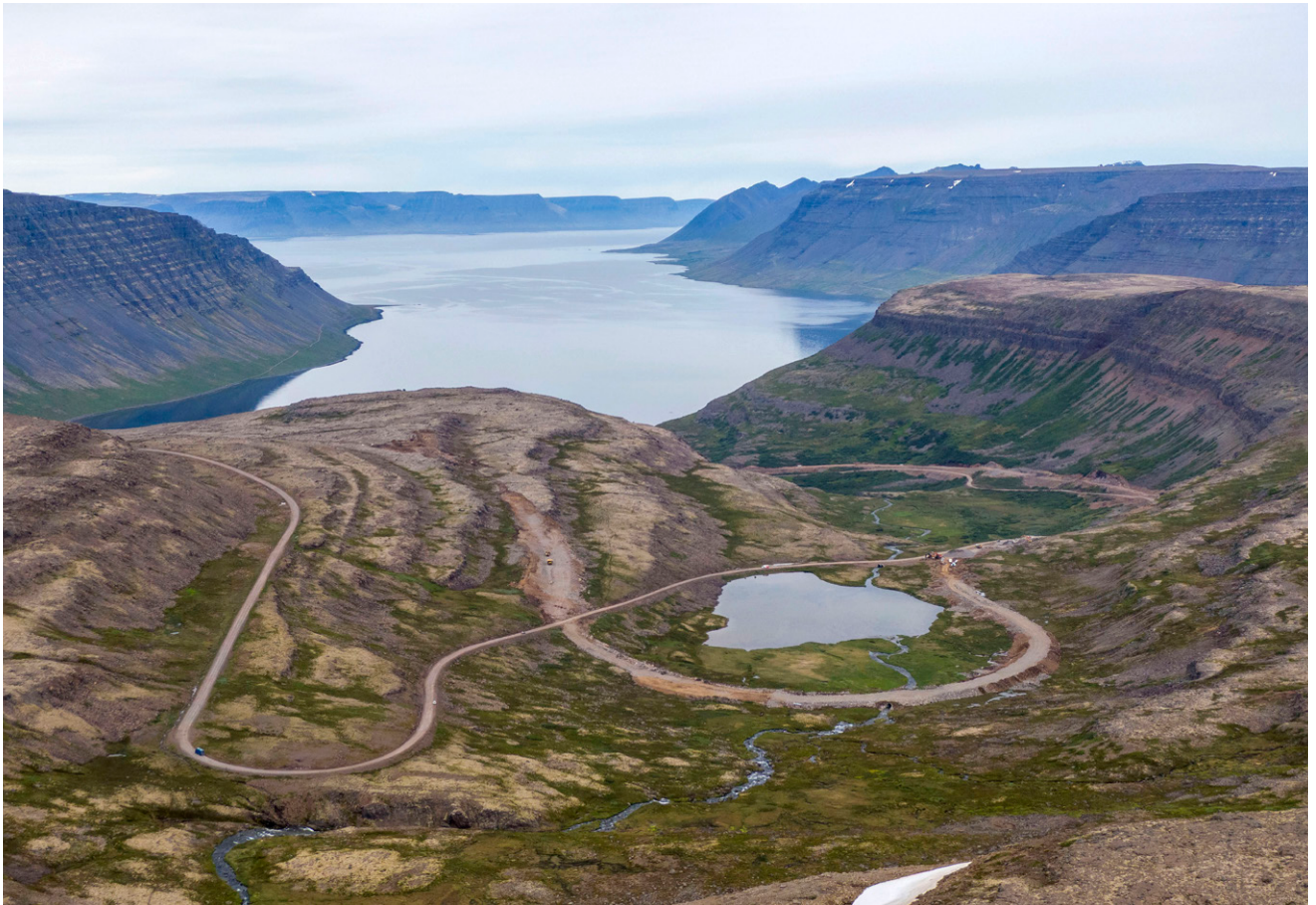
↑ Horft yfir Arnarfjörð yfir nýja vegstæðið.
