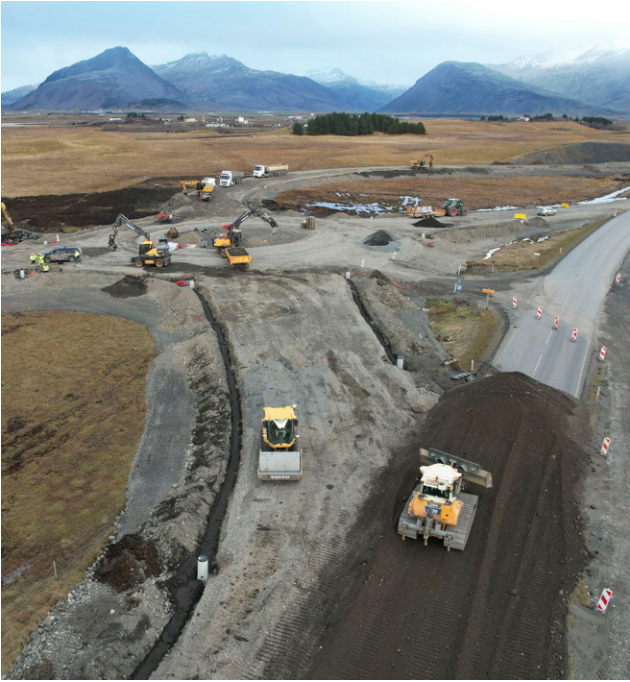
↑ Frá framkvæmdum við nýtt Hringtorg.
