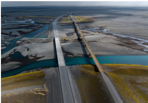
↑ Á Hringveginum eru 229 brýr og enn eru 26 þeirra einbreiðar. Hér er ný brú yfir Núpsvötn sem opnuð var árið 2023 og við hlið hennar eldri einbreið brú.
