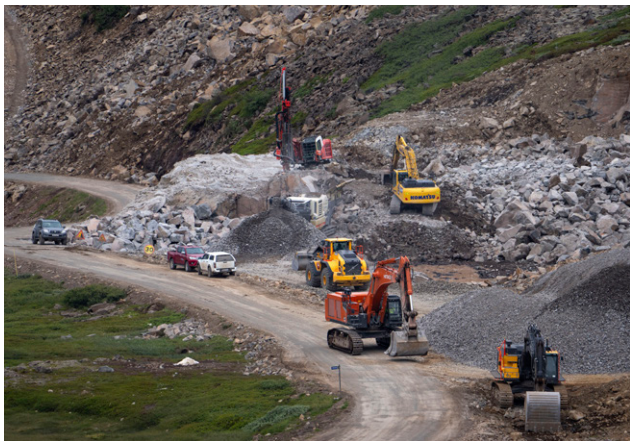
↑ Vegaframkvæmdir við Dynjandisveg.
