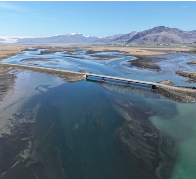
↑ Brúin yfir Hoffellsá á framkvæmdatíma.
