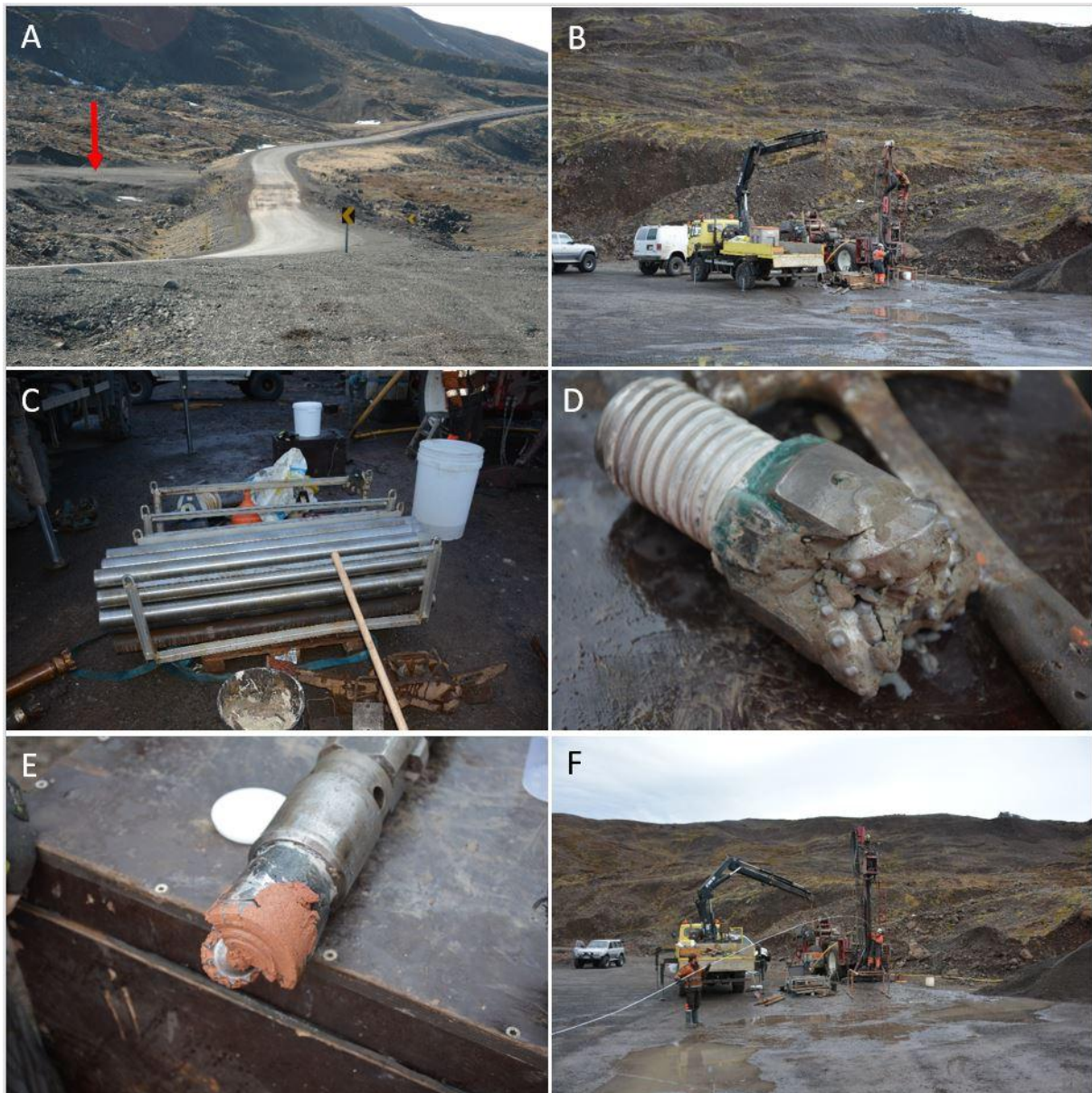
Mynd 5. A. Vegurinn um Skógarsvæðið í Tjarnardalabergghlaupinu. Misgengi sker veginn og var borholunni valin staður sunna megin við það (sjá ör). Allt að 70-80 cm færsla er á þessu misgengi á ári að meðaltali. B. Borstæðið. C. Borrörin voru 3,5" í þvermál og hvert rör 1,5 m á lengd. D. Mikið mæddi á borkrónunum sem voru 3" í þvermáli inn í 3,5" borröri. E. Að borun lokinni var komið fyrir Coaxial kapli fyrir í holunni, borrörin dregin upp og holan fyllt með Bentonite jafnóðum.
