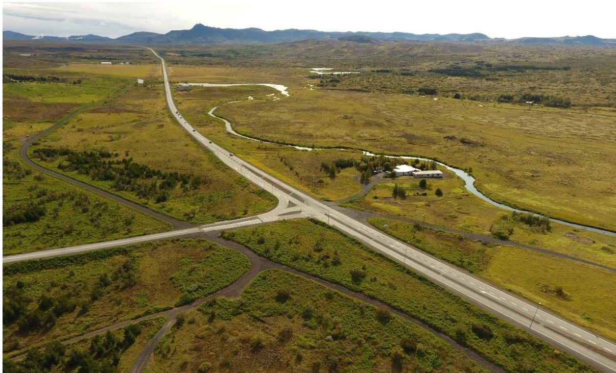
MYND 3.6 Núverandi vegamót við Hafravatnsveg. Mynd: EFLA, 2021.
