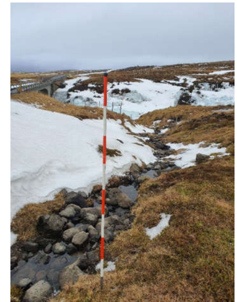
Mynd 9: Veglína (ca. við stöng) nýs vegar og brúarstæði nýrrar brúar við Dunká
