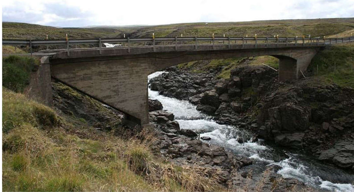
Mynd 5: Núverandi brú yfir Dunká
