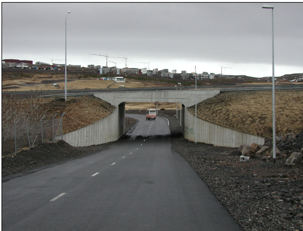
Mynd 7. Undirgöng við Krókháls, horft í austur (2002).
