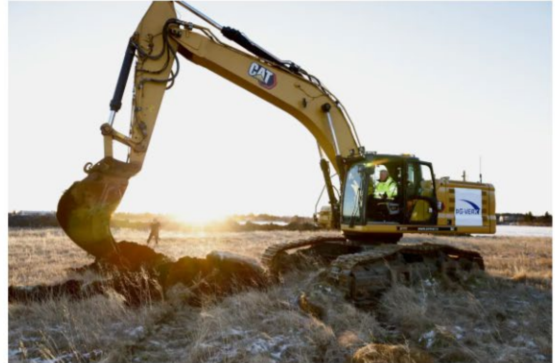
Sigurður Ingi Jóhannsson tekur fyrstu skóflustunguna að nýrri brú yfir Ölfusá 20. nóvember 2024.
