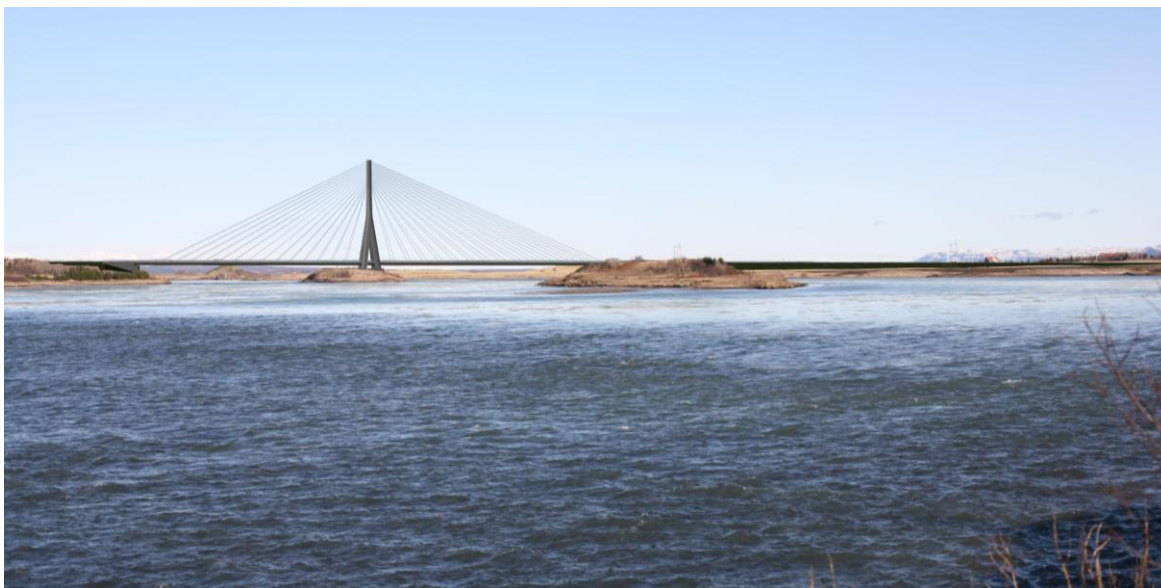
Mynd 3-4 Stagbrú við Efri Laugardælaeyju séð frá austurbakka Ölfusár.
