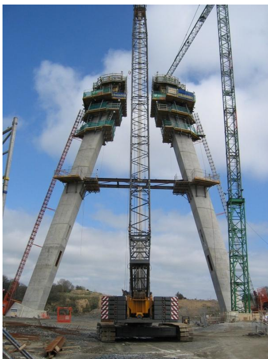
Mynd 3-11 Dæmi um mótakerfi fyrir turn af svipaðri stærð og við Ölfusá, River Suir brú í Waterford á Írlandi. Mynd og upplýsingar frá DOKA, Ireland.
