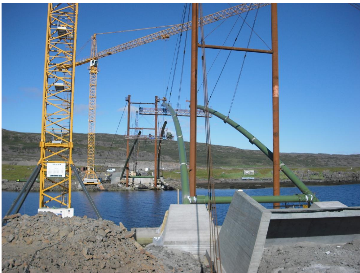
Mynd 4-7 Reising stálboga brúar á Mjóafjörð árið 2007.
