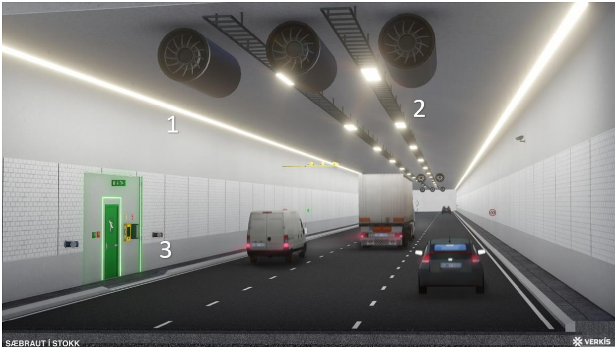
Mynd 7-1 – Almennlýsing (línur í lofti), aðlögunarlýsing (punktlýsing í lofti) og skrautlýsing í veggjum
