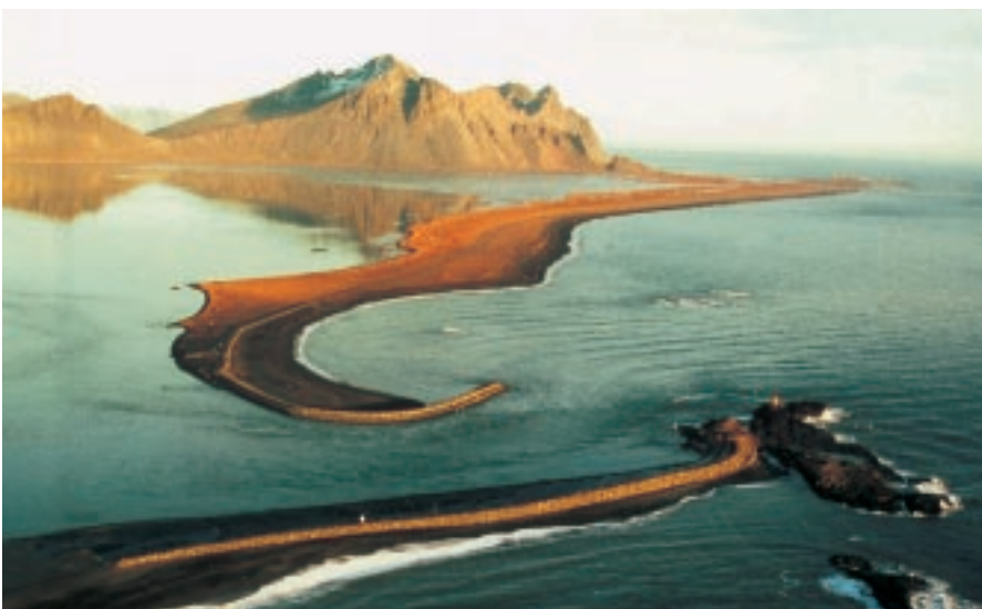
Mynd 6.4: Hér sjást sjóvarnar- og leiðigarðar við Hornafjarðarós. Öldur og straumar móta ströndina að mannvirkjum, sem hafa þann tilgang að frysta ákveðið náttúrulegt jafnvægi. Án þessara mannvirkja myndu náttúrulegar sveiflur loka Ósnum með jöfnu millibili.
