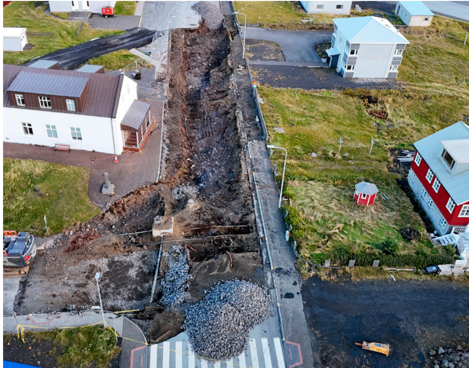
↑ Sprunguviðgerð sem stendur yfir við Víkurbraut, við húsið Kvennó.
