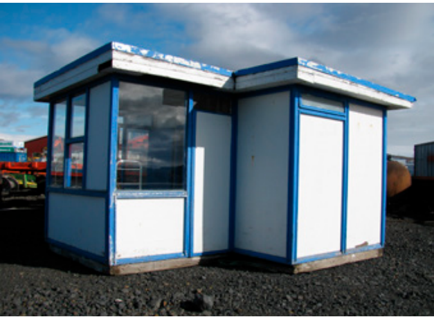
↑ Gjaldsskýli sem notað var við innheimtu veggjalds á Reykjanesbraut.
