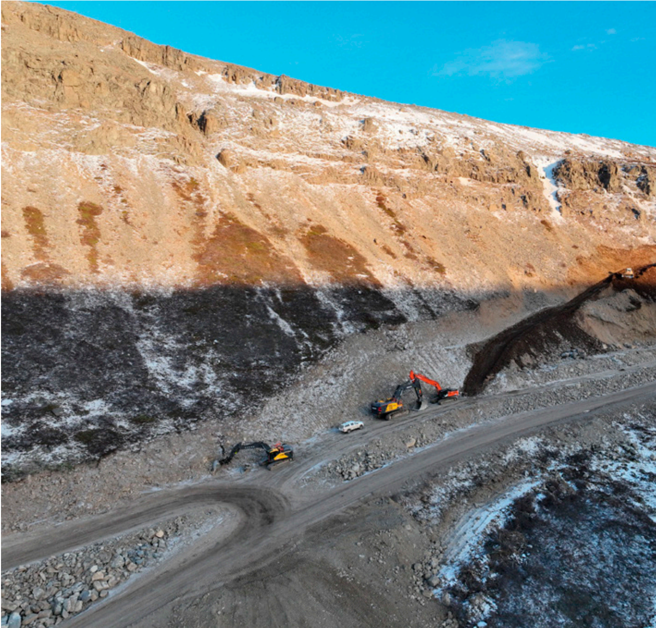
↑ Áfram verður unnið að skeringum og sprengingum.
