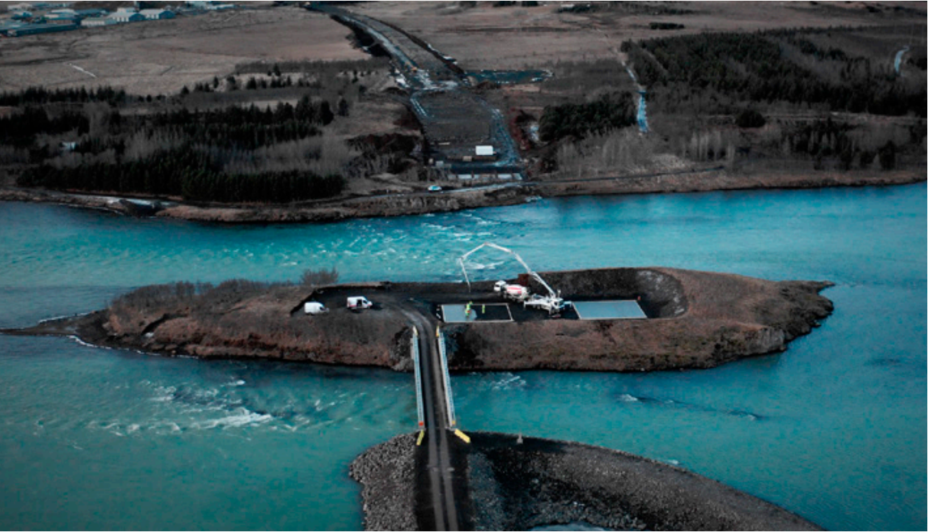
↑ Horft yfir Efri-Laugardælaeyju til vesturs. Unnið að steypu grunnlags fyrir undirstöður Ölfusárbrúar.
