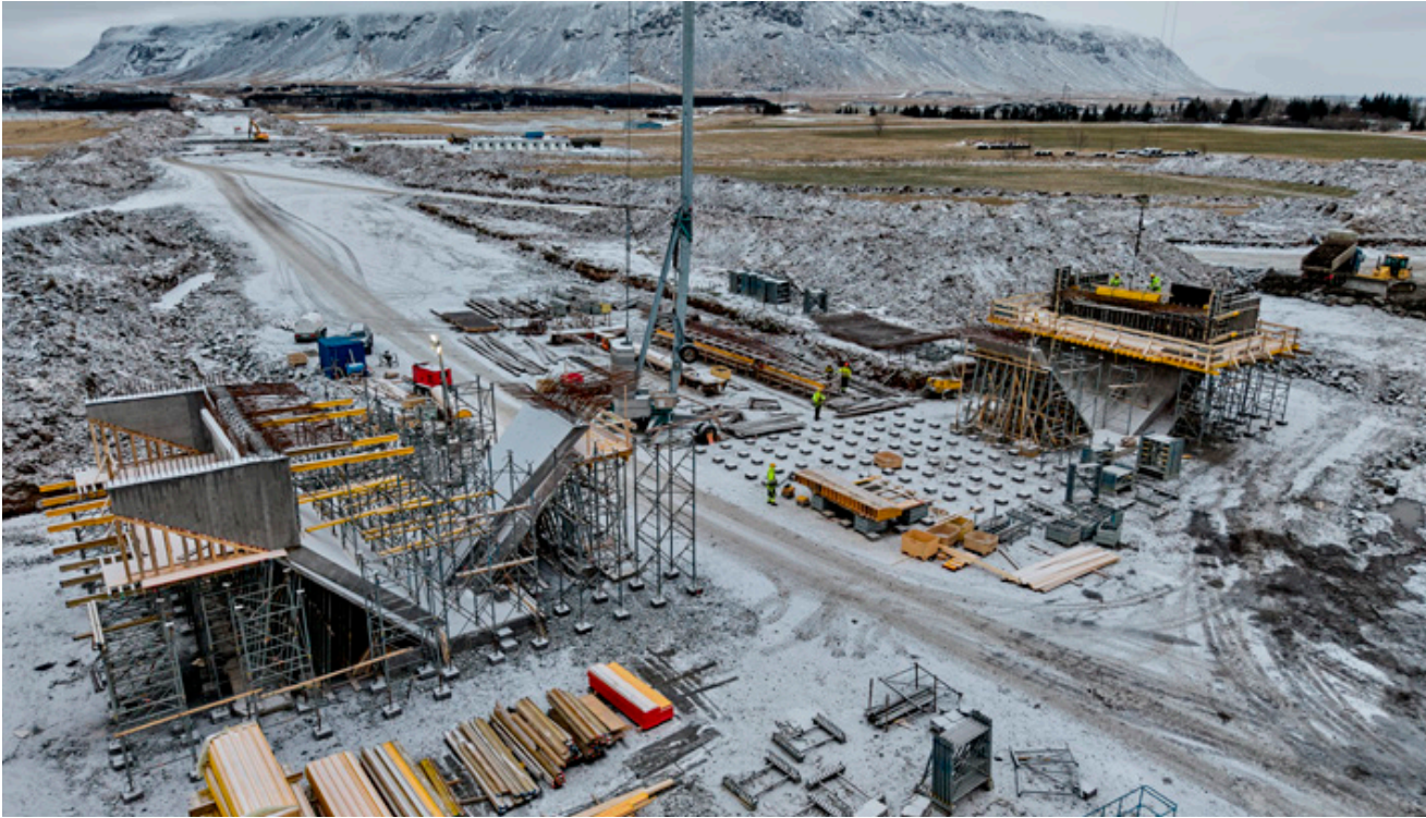
↑ Mislæg vegamót í mótun austan við Selfoss. Nýi Hringvegurinn mun liggja undir brúna.
