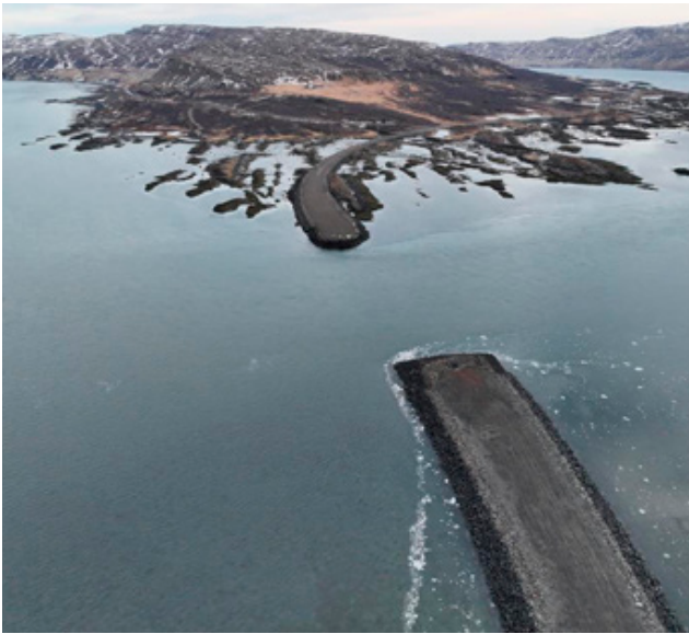
↑ Í Djúpafirði hefst fljótlega bygging 58 m langrar brúar.
