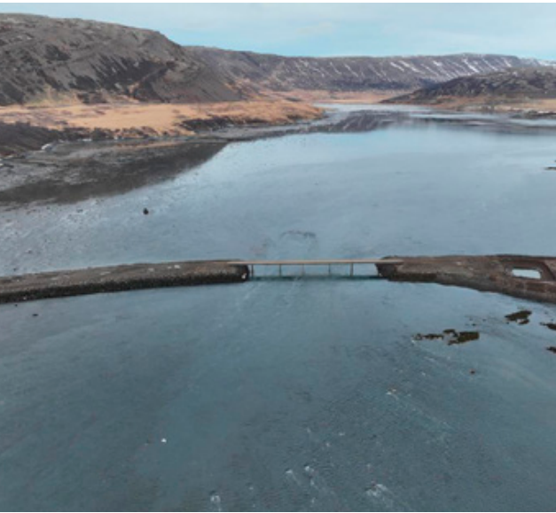
↑ Í Gufufirði er verktakinn kominn á svæðið og er vinna hafin við byggingu á 130 m langri brú með greftri fyrir stöplum brúarinnar.
