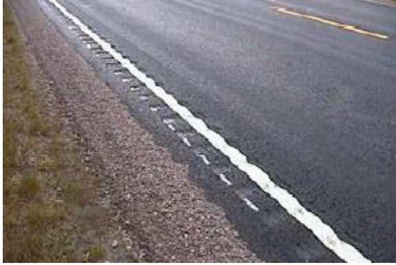
MYND 12 Til vinstri – sínuslaga vegriffur ásamt venjulegri vegmerkingu í botni fræsingarinnar. Til hægri - sínuslaga vegriffur með dropalaga vegmerkingu í botni fræsingarinnar [11, mynd 4].
