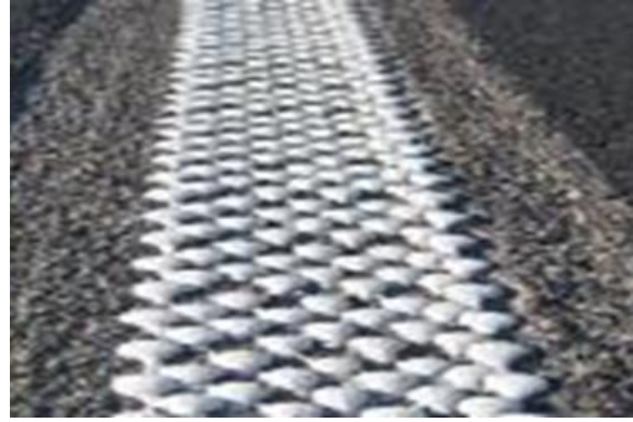
MYND 12 Til vinstri – sínuslaga vegriffur ásamt venjulegri vegmerkingu í botni fræsingarinnar. Til hægri - sínuslaga vegriffur með dropalaga vegmerkingu í botni fræsingarinnar [11, mynd 4].
