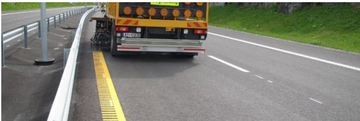
MYND 8 Greiðulaga veggrifflur (no. kamflex), massaðar [15, Mynd 3.7].
