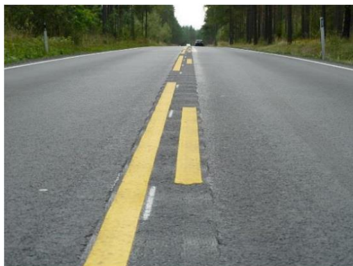
MYND 13 Til vinstri: Vegmerkingar málaðar í botn sínuslaga vegriffa [15, mynd 1.5]. Til hægri: Fræsari fyrir vegriffur (e. rumble strip grinder), sótt af http://www.roadproonline.com/rumbler.html .
