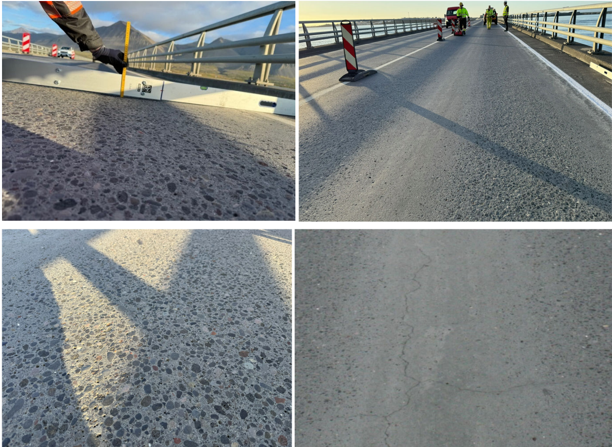
Mynd 10 – Sjónmat yfirborðs Borgarfjarðarbrúar 2024.
