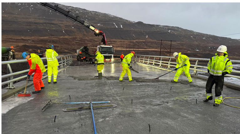
Mynd 1 - Sérstök slitlagssteypa 50 mm á þykkt lögð á nýja brú yfir Fjarðarhornsa á Vestfjörðum í desember 2024.
