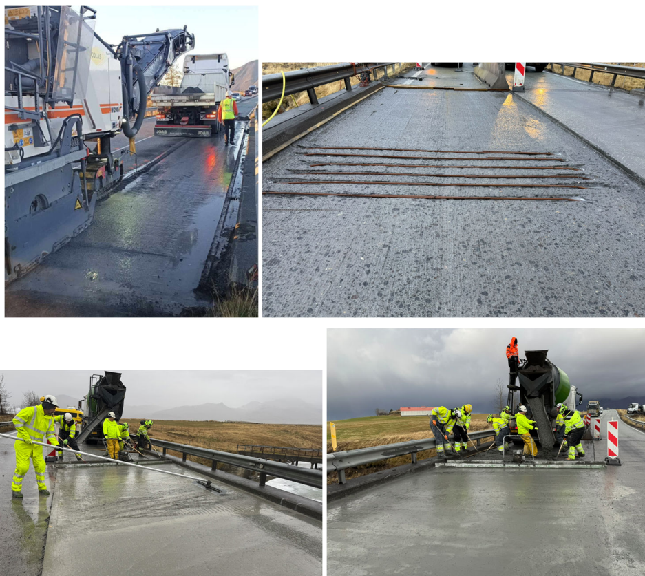
Mynd 17 – Viðgerð á yfirborði Laxárbrúar í október 2024. Sem fólst í fræsingu, steypubroti og lagningu slitlagssteypu. Ein akrein var tekin fyrir í einu, umferð var ljósastýrt á meðan.
