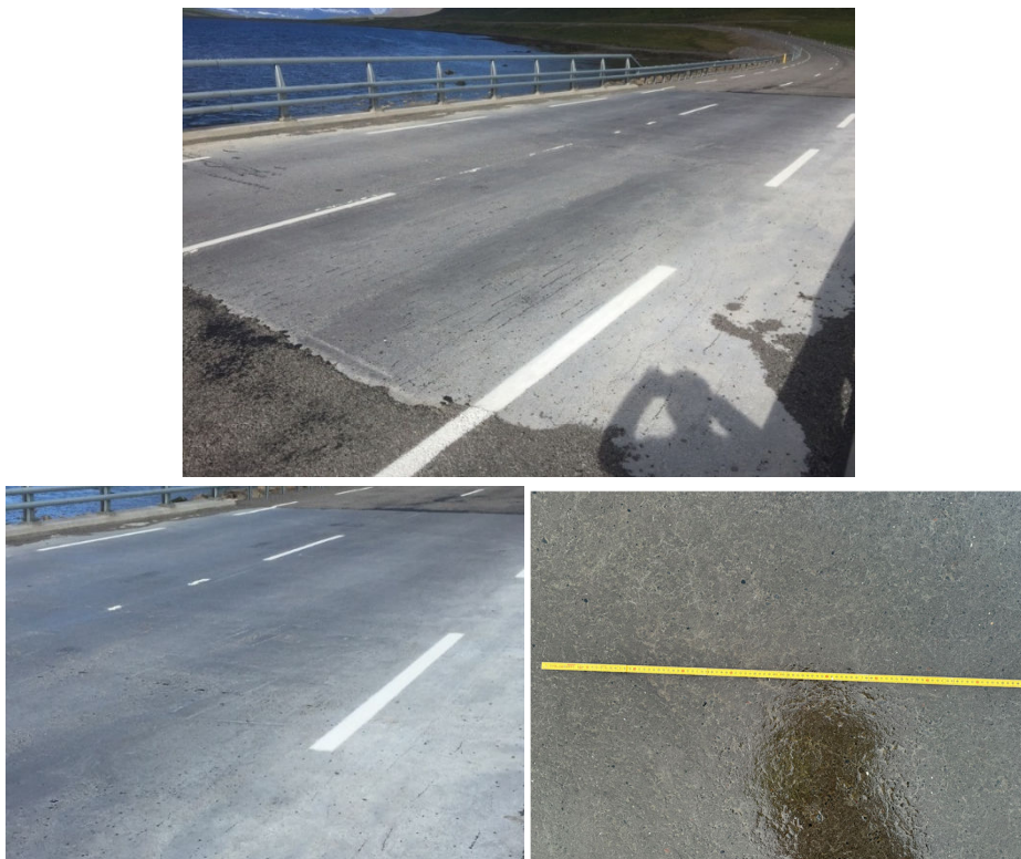
Mynd 26 – Sjónmat yfirborðs brúar yfir Bjarnadalsá 2022 (efri myndin) og 2024 (neðri myndirnar).
