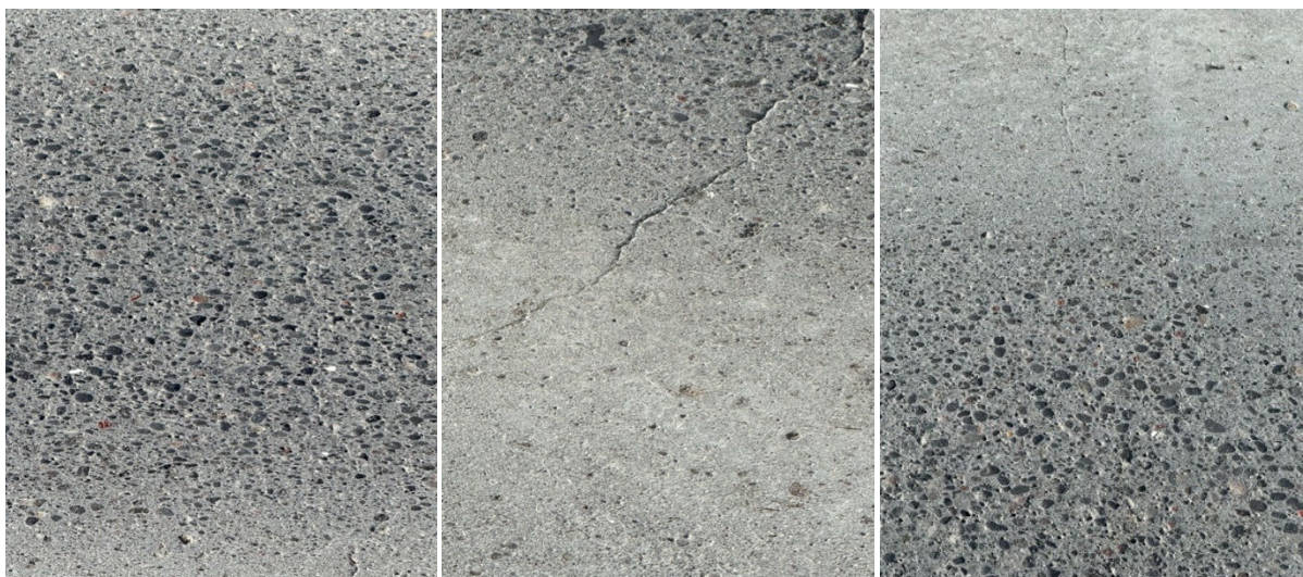
Mynd 14 – Sjónmat yfirborðs Ölfusárbrúar.
