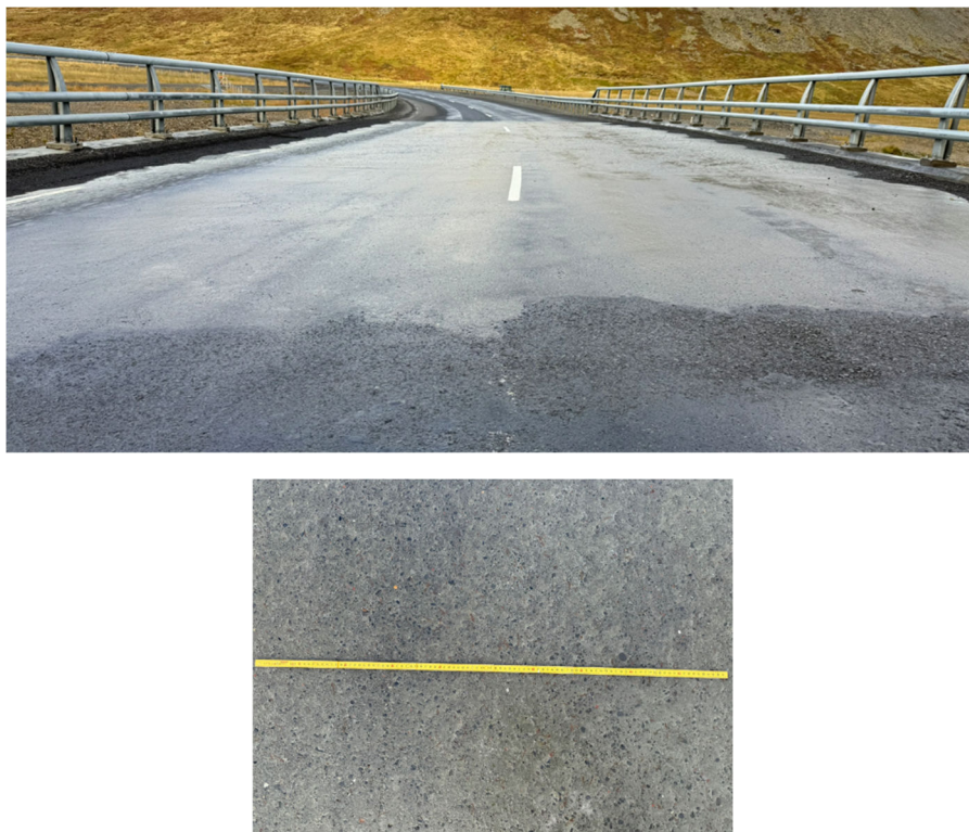
Mynd 28 – Sjónmat yfirborðs brúar yfir Botnsá 2024.
