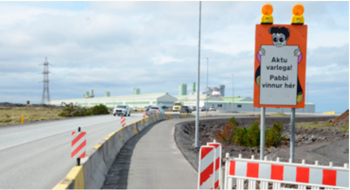
↑ Fólk hvatt til að aka varlega um framkvæmdarsvæði á Reykjanesbraut.
