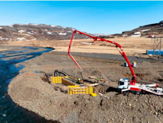
↑ Tvær brýr yfir Fjarðarhornsa og Skálmardalsá Verkið Vestfjarðavegur (60) um Fjarðarhornsa og Skálmardalsá felst í nýlagningu og endurbýggingu Vestfjarðavegar á tveimur aðskildum köflum, sitthvorumegin við fjallveginn Klettsháls eða samtals um tveir kílómetrar. Innifalið í verkinu er bygging tveggja steinsteyptra, eftirspenntra, plötubrúa í tveimur höfum yfir Fjarðarhornsa og yfir Skálmardalsá. Brýrnar tvær verða mjög áþekkar. Báðar verða 34 metra langar með 9 m breiðri akbraut og 0,5 m breiðum kantbitum. Slitlag brúanna verður úr hástyrkleikasteypu. Vegagerðin er að mestu nýlagning með tengingu frá núverandi vegstæði að nýjum brúarstæðum og færslu á afleggjurum. Verkið í heild á að klárast í desember 2025. Verktaki: VBF Mjólnir ehf.
