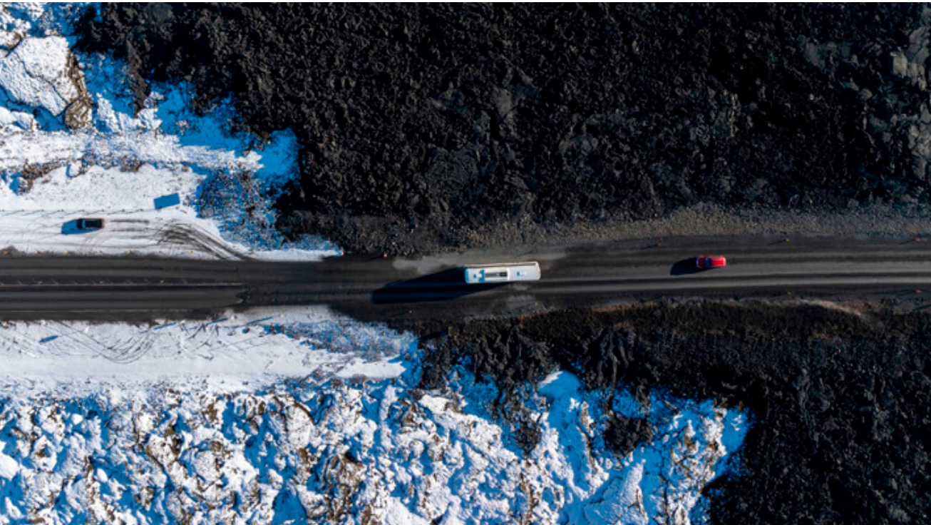
↑ Leggja þurfti veg yfir nýrunnið hraun á Grindavíkurvegi. Mynd: Vilhelm Gunnarsson
