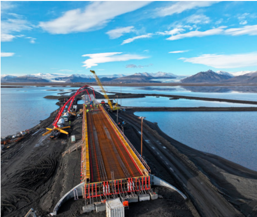
↑ Hringvegur (1) um Hornafjörð Framkvæmdir við verkið Hringvegur (1) um Hornafjörð voru í fullum gangi árið 2024. Um er að ræða nýja legu Hringvegarins um Hornafjarðarfljót sem mun stytta núverandi Hringveg um 12 km. Framkvæmdin felur í sér lagningu 19 km langs þjóðvegur og 9 km af hliðarvegum, byggingu fjögurra tvíbreiðra brúa auk tveggja áningarstaða. Verktaki: Ístak
