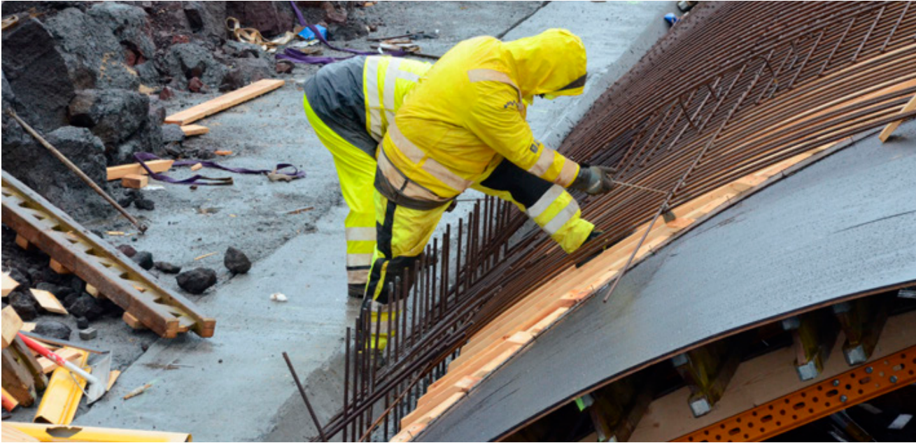
↑ Frá framkvæmdum við tvöföldun Reykjanesbrautar.
