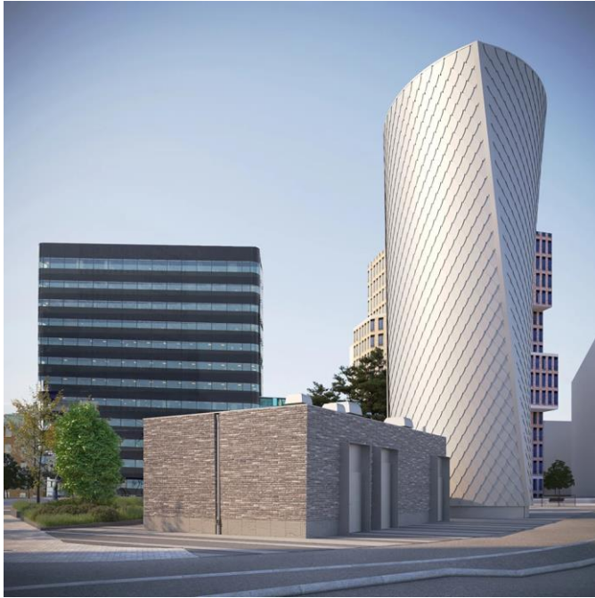
MYND 4.60 Loftunarturnar í Svíþjóð. Götatunneln, Gautaborg (vinstri, tölvugerð mynd) og Norra Länken, Stokkhólmi (hægri)
