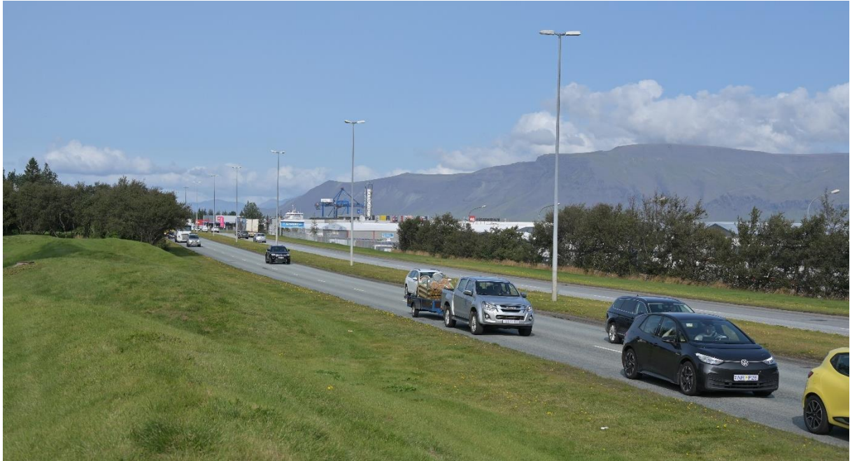
MYND 4.7 Horft til norðurs meðfram Sæbraut í Reykjavík. Í bakgrunni má sjá Esjuna. Mynd: EFLA, 2024.
