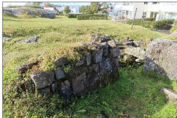
Mynd 13. Norðausturhlið á L-laga hleðslu við brekkuna.
