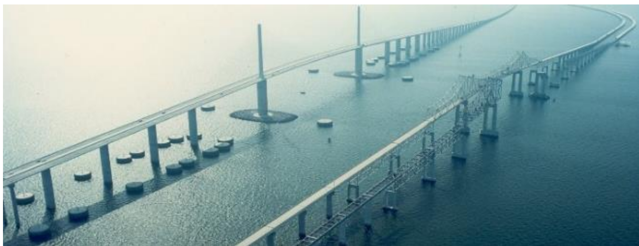
MYND 2 Sunshine Skyway brú yfir Tampa flóa með steiptum „dolphins“ og grjótvörðum stöplum (Heimild: "Sunshine Skyway Bridge," Wikipedia, last modified April 30, 2025, https://en.wikipedia.org/wiki/Sunshine_Skyway_Bridge ).
